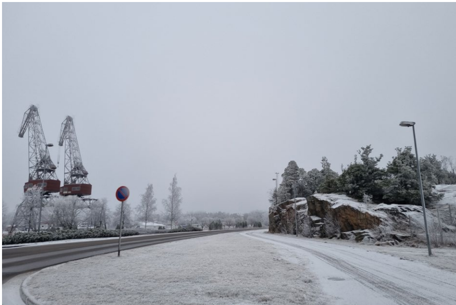
Kuva 25. Kuvattu Suojantieltä, vasemmalla teollisuus alue ja oikealla leikattu kallio.
