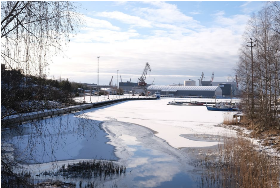
Kuva 23. Kanaalin päädystä, Suojantie, länteen.
