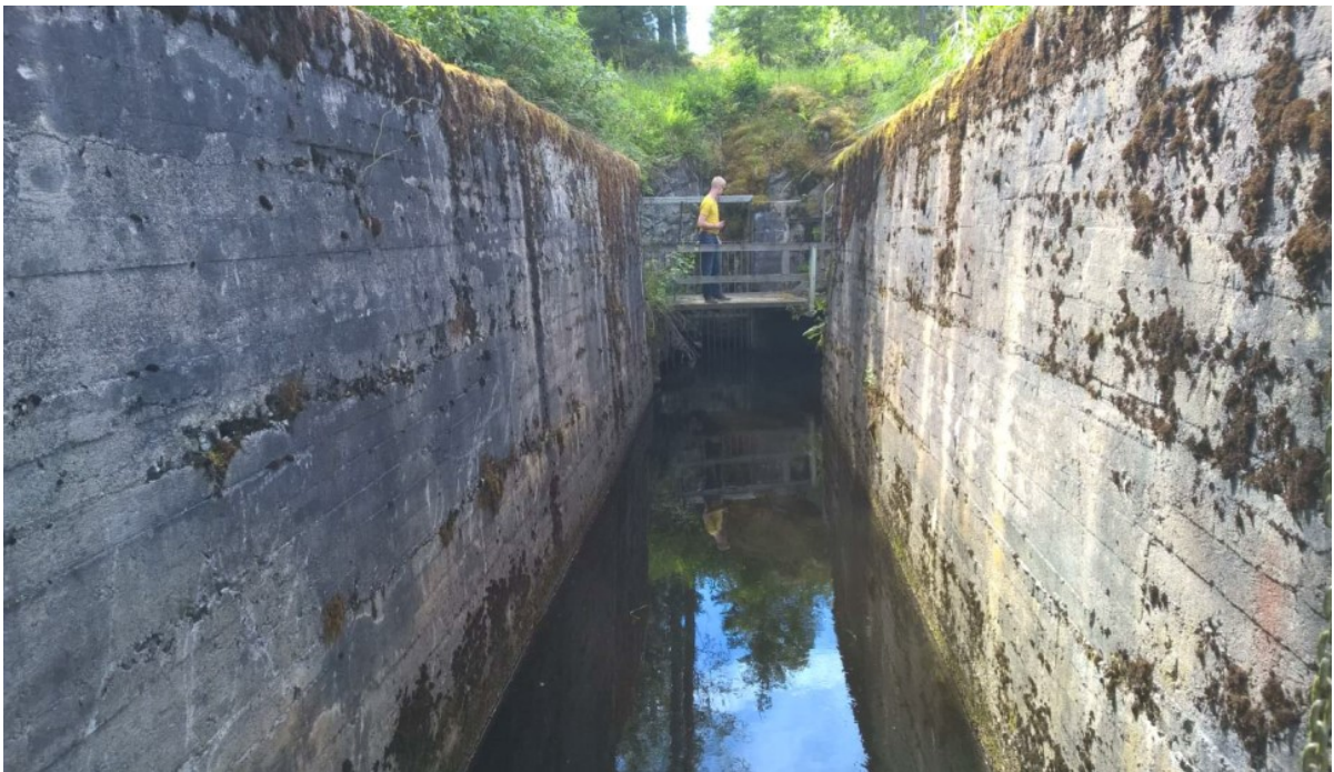
Kuva 2-1: Raakavesikanavan kalliotunneliosan alku kaava-alueen koillispuolella.
