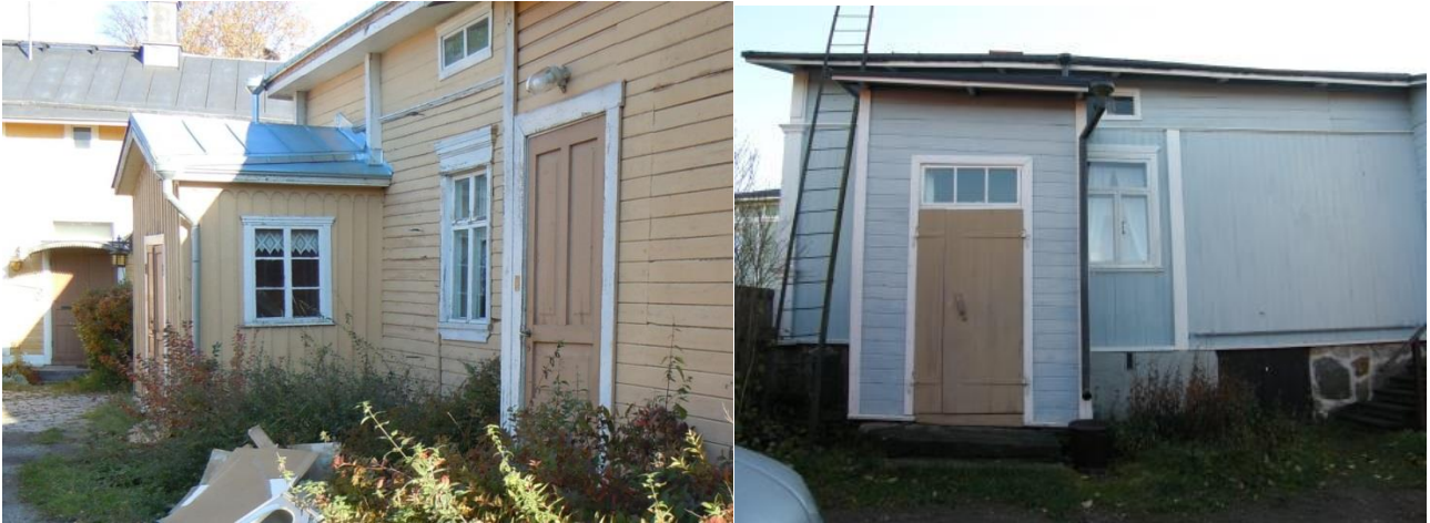
Joki-Martin kuisti on 1800-luvun puolelta. Oikealla Sandlan päärakennuksen vanha kuisti ja vanhaa pystylautavuorausta sisäpihan puoleisessa julkisivussa.
