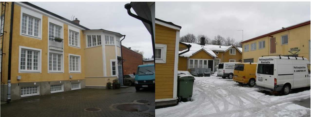
Vasemmalla Konstarin entinen pläkkitehdas nykyisin asuinrakennukseksi muutettuna. Porrastorni on uudisrakenne. Oikealla Patolan leipomo, joka nykyisin on peltisepän verstaana.
