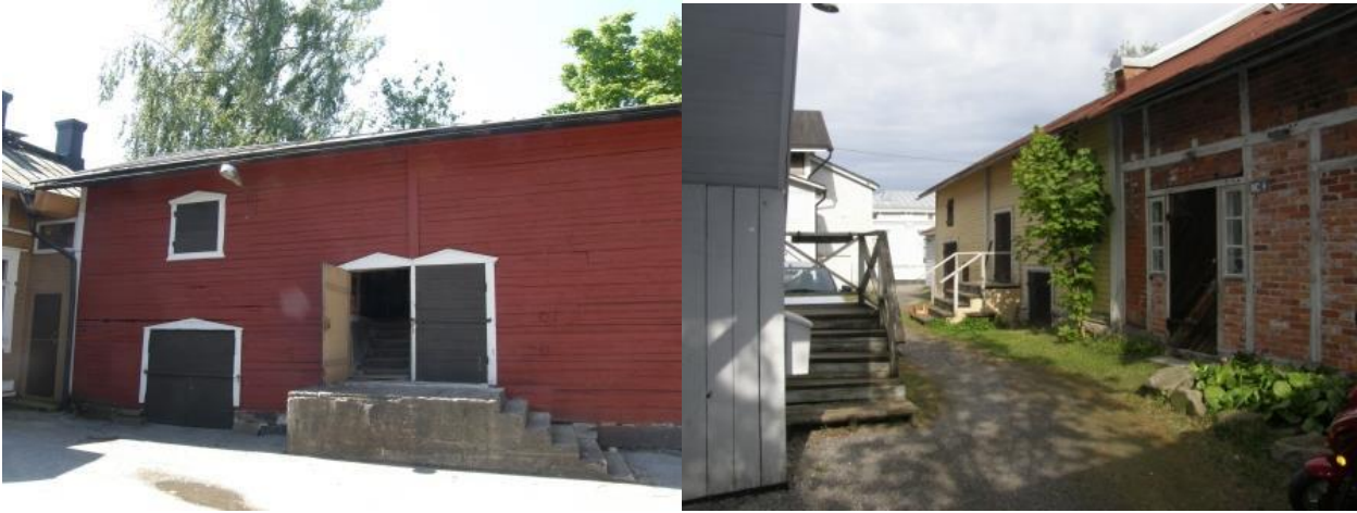
Vasemmalla kauppias Ivan Sofronoffin Rännärin tontille rakennuttama varasto ja oikealla Maalarin kahdessa vaiheessa rakennettu liikkeen varasto. Kummankin varaston alla on kaksiosainen holvikellari.
