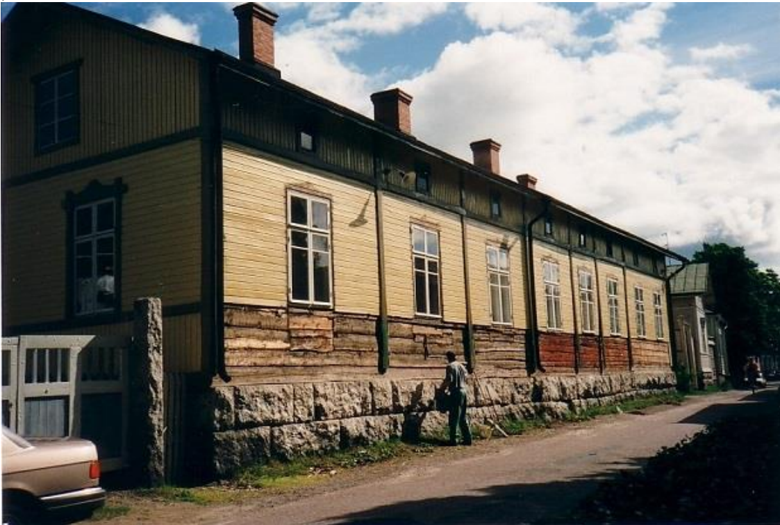
Enwallan päärakennuksen kunnostus 1990-luvulla. Kuva: Timo Tuomola
