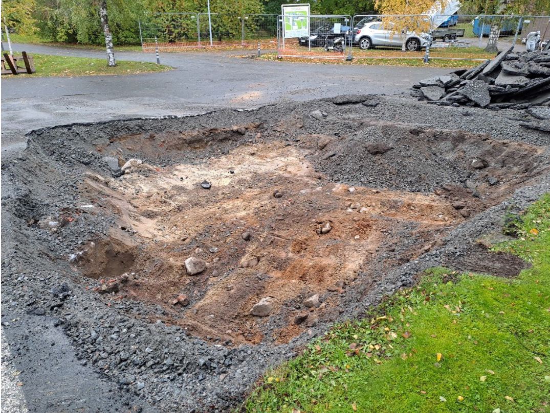
Kuva 01 – Eteläisen alueen kaivanto.
