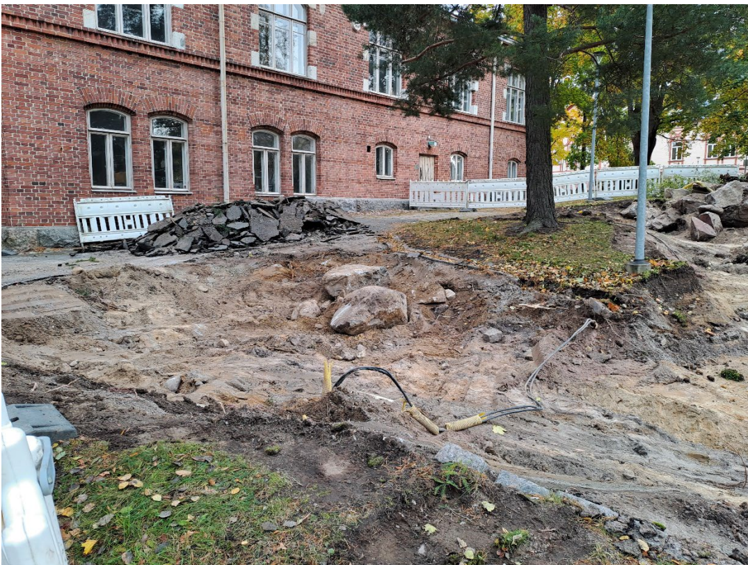
Kuva 02 – Pohjoisen alueen kaivanto.
