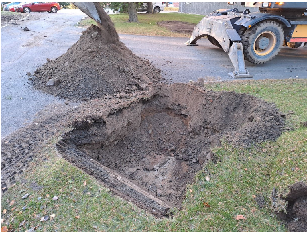
Kuva 04 – Koekuoppien kaivuuta pohjoisen alueen länsipuolella.
