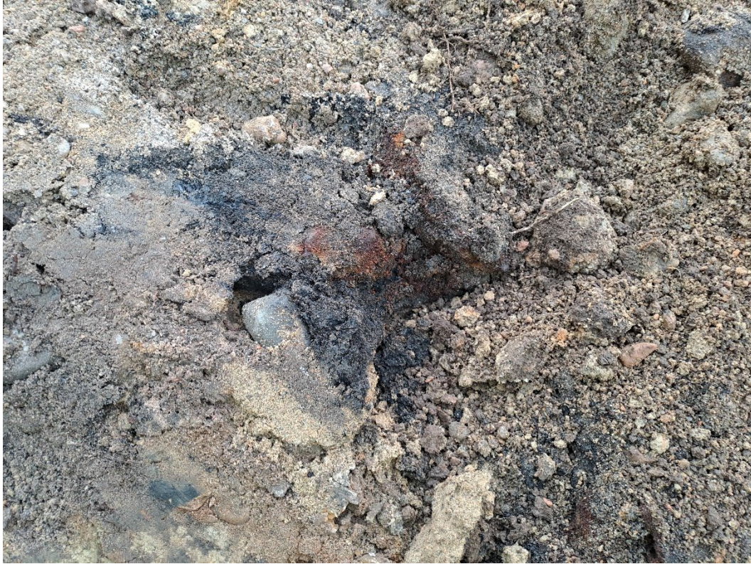
Kuva 03 – Tummaa täyttömaa-ainesta pohjoisen alueen kaivannossa.
