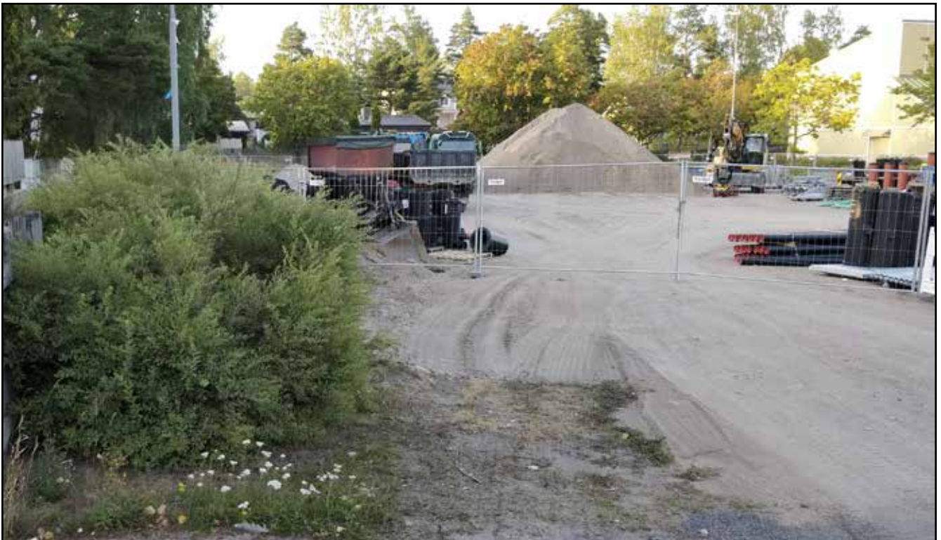
Koulun sisäpihan työmaata.
