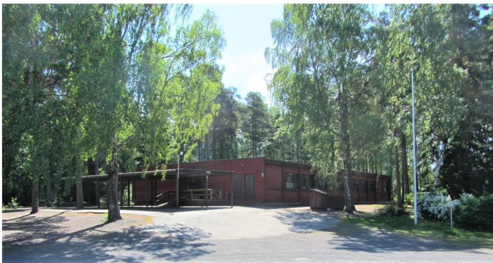
Kuva 3. Merirauman koulun pohjoispäätyä ja läntistä julkisivua. Ramppi oli lisätty pääsisäänkäynnin yhteyteen myöhemmin.
