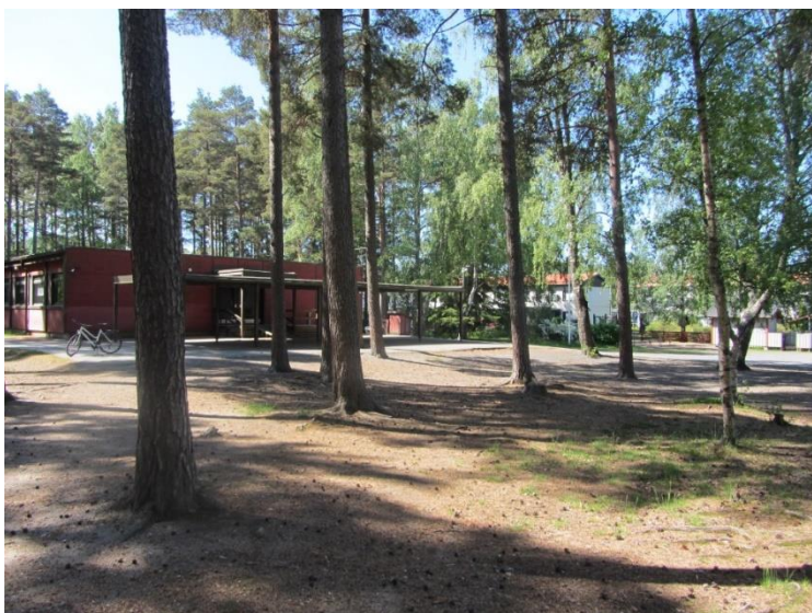
Kuva 2. Merirauman koulun pohjoispäätyä.
