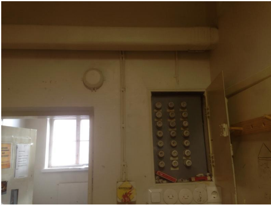
Kuva 48: Asbestisementtiputki katon rajassa
