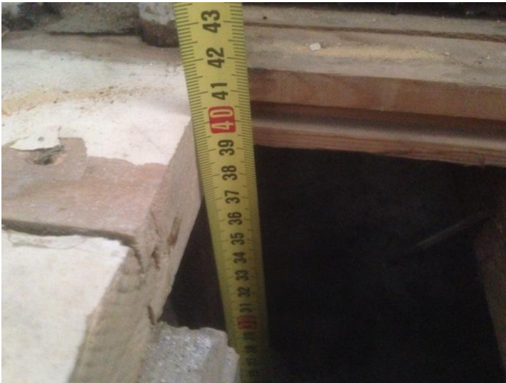
Kuva 8: Välipohjan rakennesyvyys
