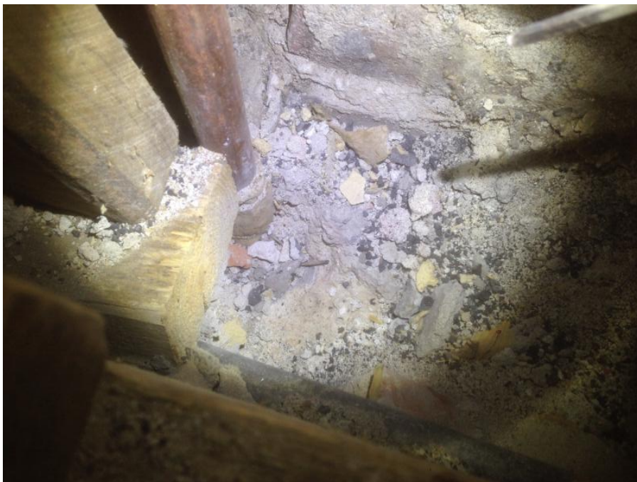
Kuva 11: Materiaalinäyte 2: toisen kerroksen välipohjan eristestilan täyttö
