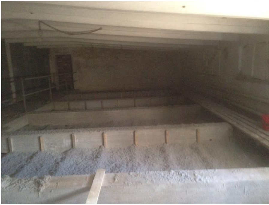
Kuva 95: Korjatun autotallin kohdalla yläpohja
