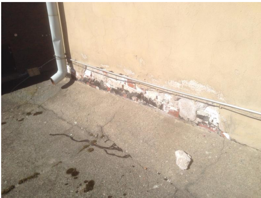
Kuva 90: Korkean ja matalaosan liitoskohta avonainen
