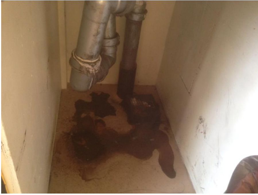
Kuva 52: Hajulukkovuoto 3. kerroksen keittiössä
