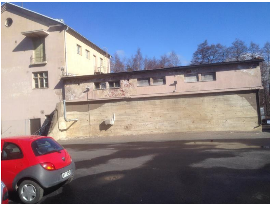
Kuva 101: Matalaosa sisäpihalta kuvattuna
