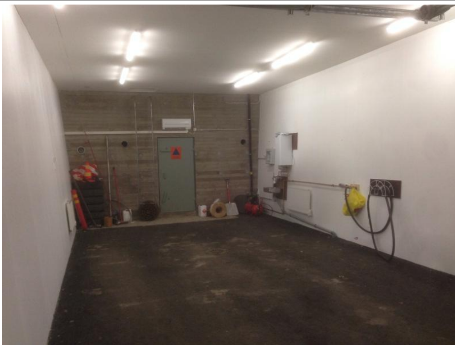
Kuva 94: Autotalli, joka on peruskorjattu. Lattiassa asfalttipinnoite
