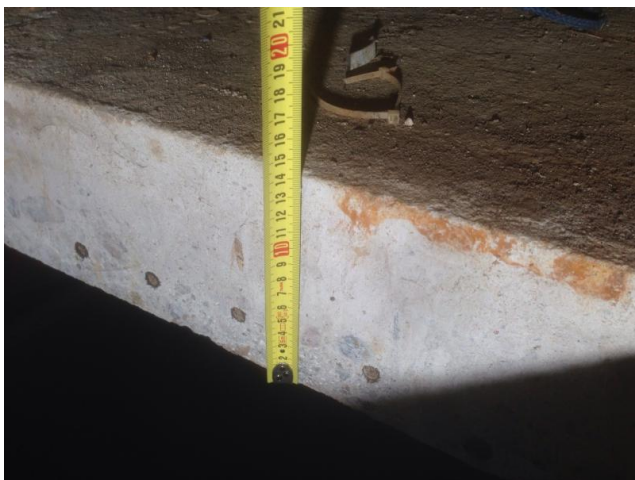
Kuva 6: Lattiarakenne osittain vesisäiliötilan kohdalla.
