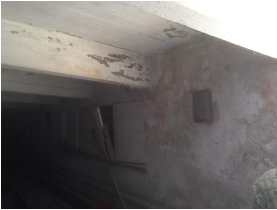
Kuva 97: Kosteusvaurioita rakenteissa
