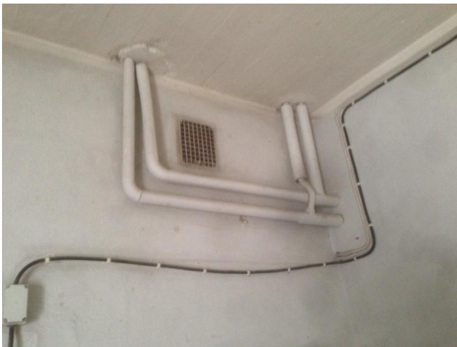
Kuva 43: Asbestieristeisiä lämpöputkia keramiikkahuoneen katon rajassa
