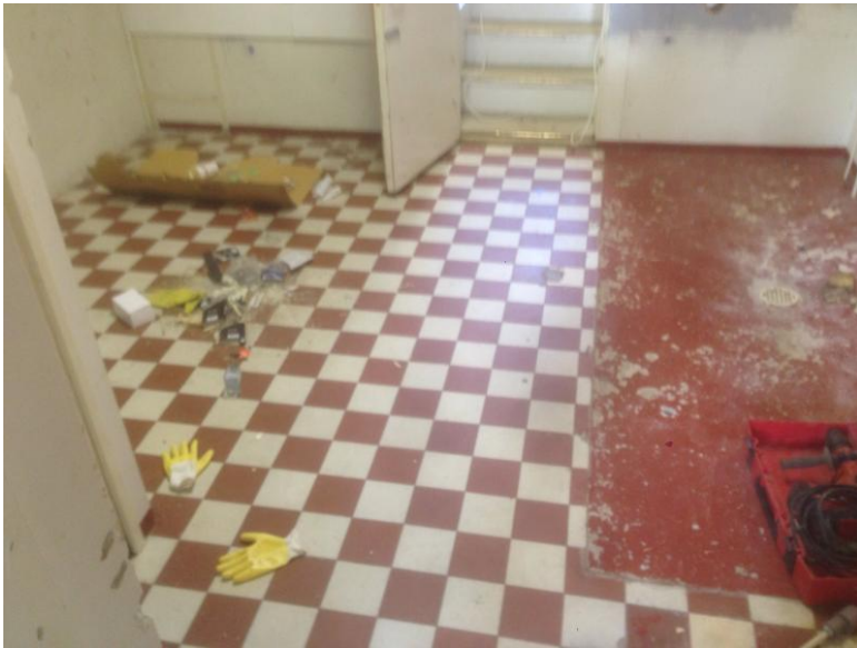
Kuva 9: 2. kerroksen tällä alueella ylälaattapalkisto.
