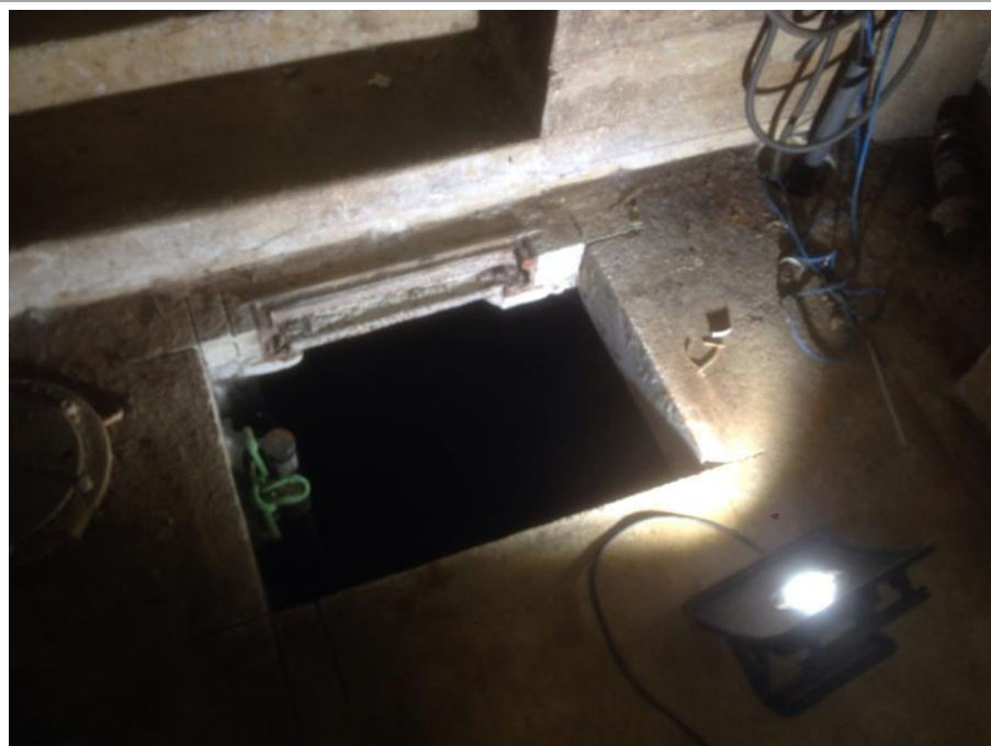
Kuva 20: Lattiassa tarkastusluukkuja
