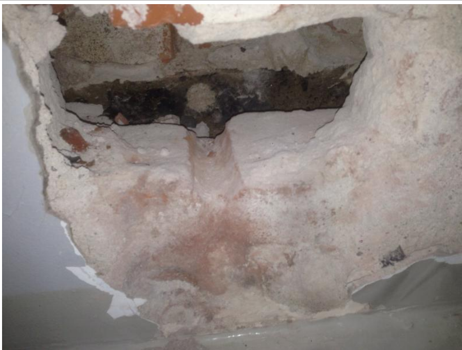
Kuva 41: Ulkoseinän rakenneavaus varastossa
