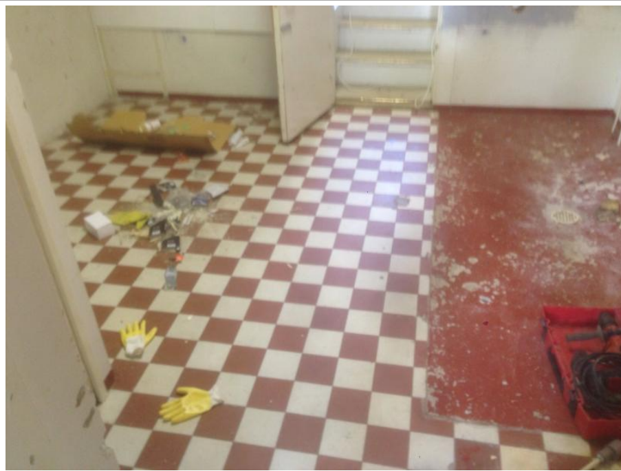
Kuva 44: Toisen kerroksen laatoitettu tila
