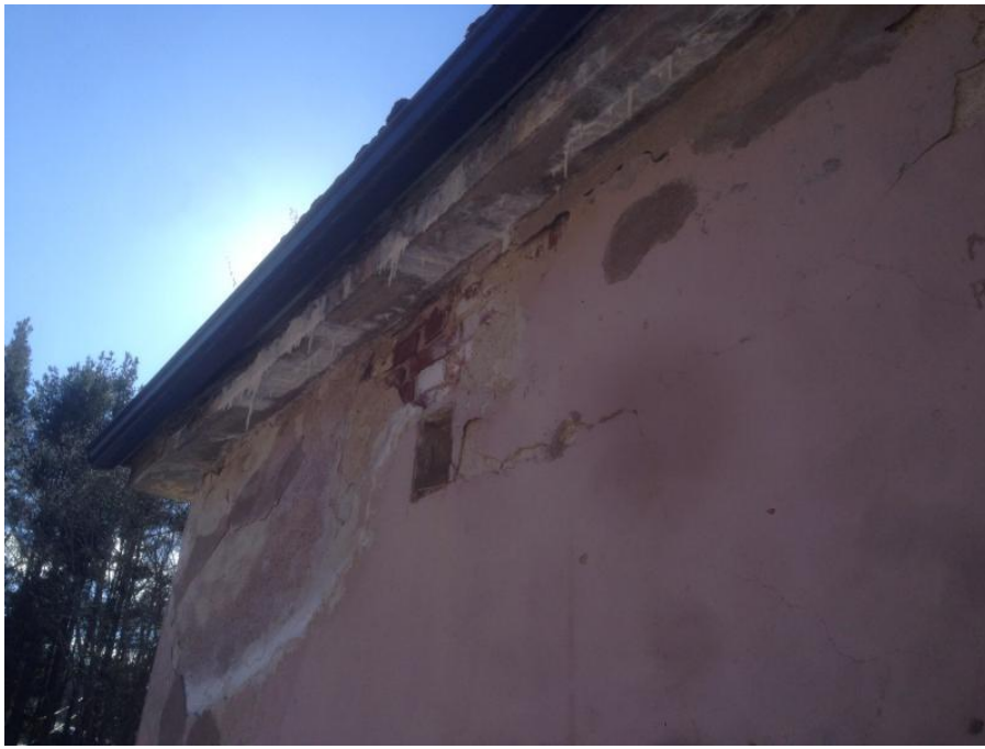
Kuva 75: Kosteusvaurioita julkisivussa
