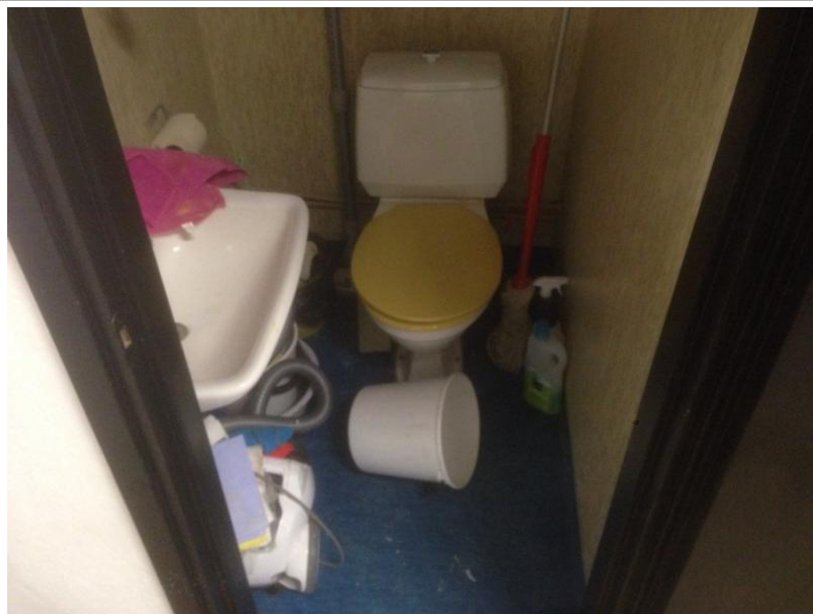
Kuva 54: Yläkerran WC, pintakosteuslukemat Gann 58-70
