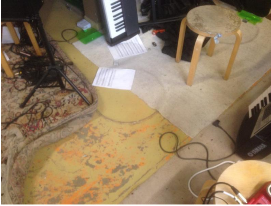
Kuva 56: 3. kerroksen "bändikämpässä" osittain teräksinen lattia
