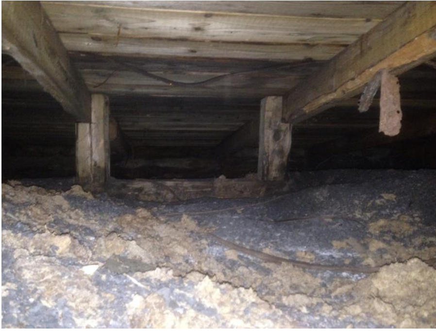
Kuva 79: Yläpohjasta yleiskuva korjaamo-osan yläpuolelta
