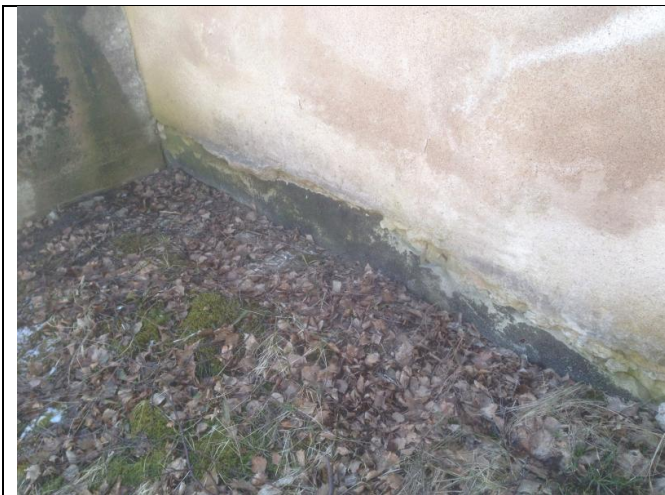
Kuva 3: Ulkoseinän alaosassa on paikoin kosteussulkuna bitumisively.
