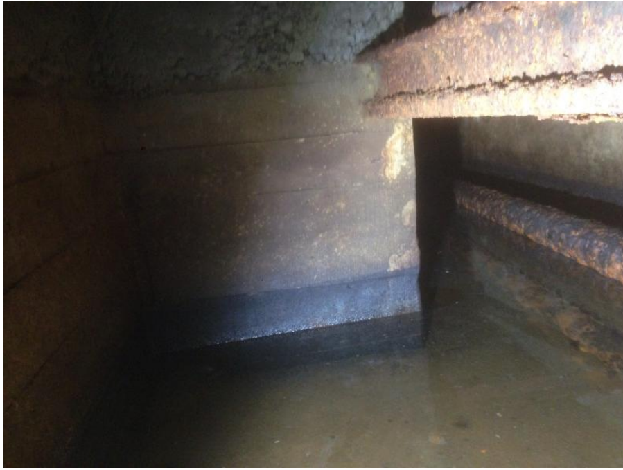
Kuva 40: Putkikanaali johtaa käytävän suuntaan
