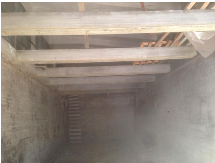
Kuva 92: Autotalli, jossa on maalattia
