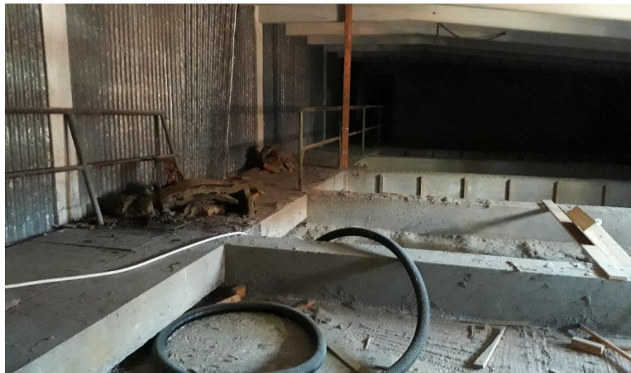
Autotallien päällä olevaa tilaa
