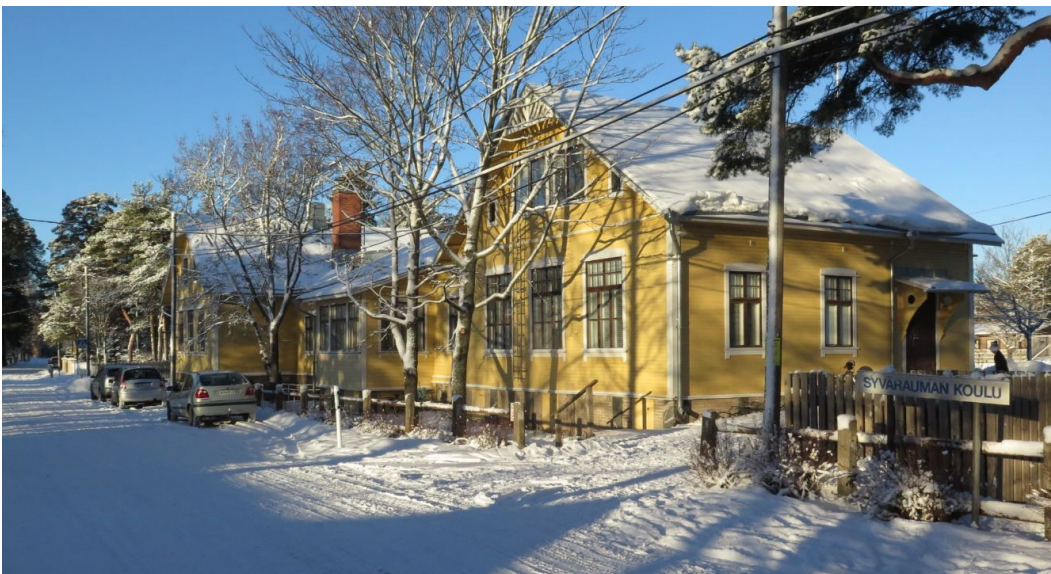
Pohjoispuolella Purjehtijankadusta oleva koulurakennus, niin kutsuttu Yläkoulu. (2019, Satakunnan Museo)
