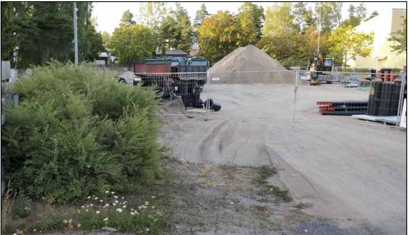
Koulun sisäpihan työmaata.
