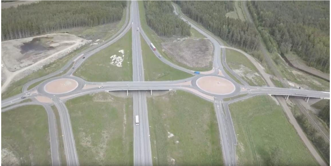
Kuva: Luostarinkylän eritasoliittymä.
