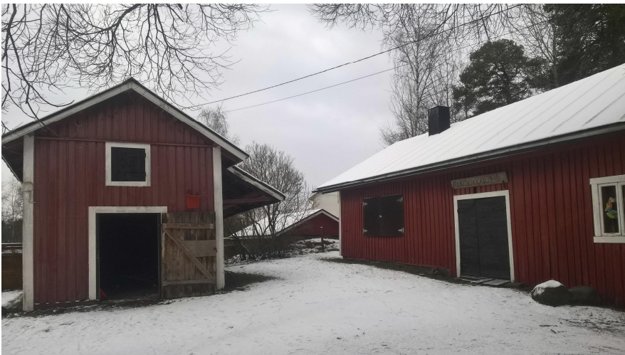
Ulkorakennusten välissä näkyy kellarin katto.
