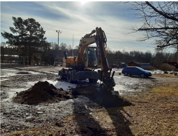
Koekuoppaa kaivetaan. (2021, Ramboll Finland Oy)
