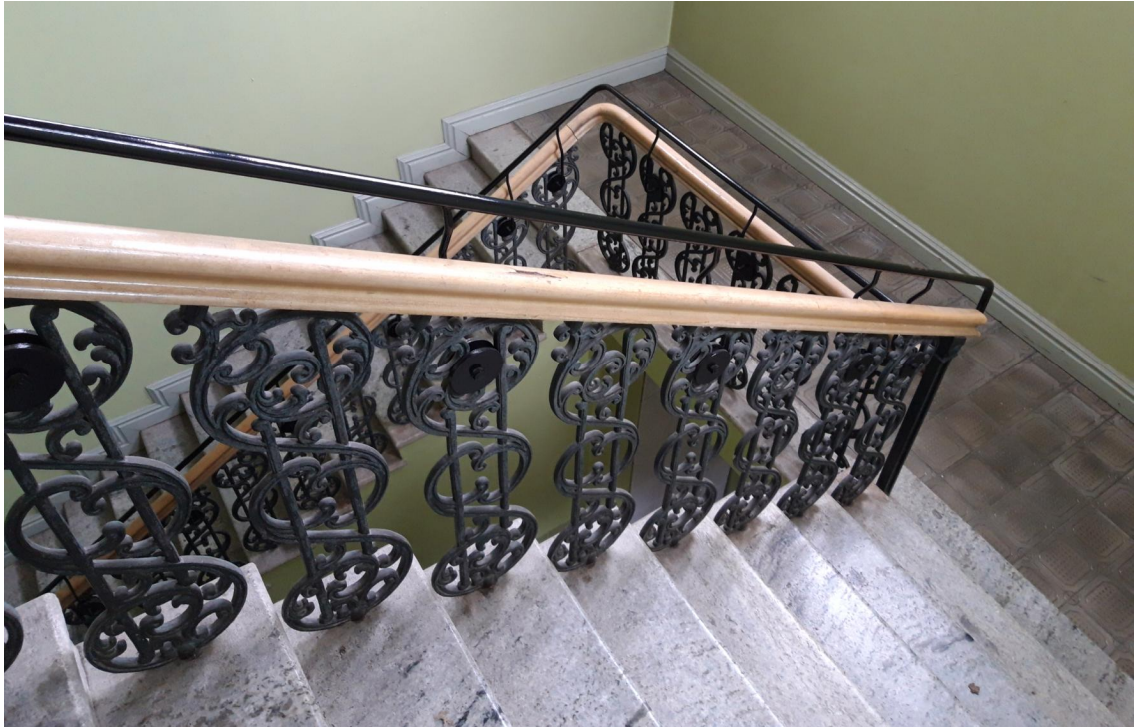
Kuva: Johtajan asuinrakennuksen porrashuone on valurautaisine kaidedetaljeineen, kiviaskelmineen, välitason laatoituksineen ja katon koristekuviopalkistoineen yksi Rauman hienoimmista vanhoista porrashuoneista.
