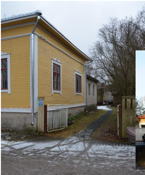
Pihajulkisivu, etualalla näkyvän laajennuksen aumakatto ympäröivästäineen noudattaa rakennuksen kattomuotoa ja kaltevuutta. Rapatun laajennusosan lisäksi 1950-lukua edustavat terassi, portaat ja niiden metallikaiteet. Vanhasta keittiökuistista on poistettu toinen ovi.
