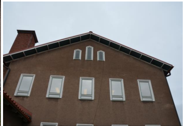
Asuinsiiven nurkkaikkuna ja eteläpäätty. Vintinpäädissä on käytetty ajalle tyypillisiä, vanhempaan rakentamiseen viittaavia kiilaikkunoita. Erkkeri kunnostettiin 2010-luvulla.
