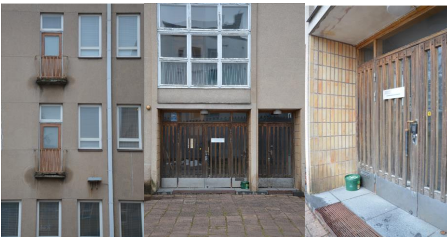
Sisäpihan detaljeja, metalliparvekkeet ja ovet. Oikealla on oma sisäänkäynti ja porras vahtimestarin asuntoon.
