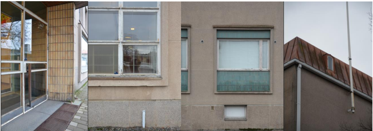
Pääsisäänkäynti, länsipäädyn korkea ikkuna, itäpäädyn kehystetty ja vihreällä klinkkerillä rajattu ikkuna, jonka takana oli vahtimestarin asunto. Katto, kattolyhty, vesikouru- ja syöksy.
