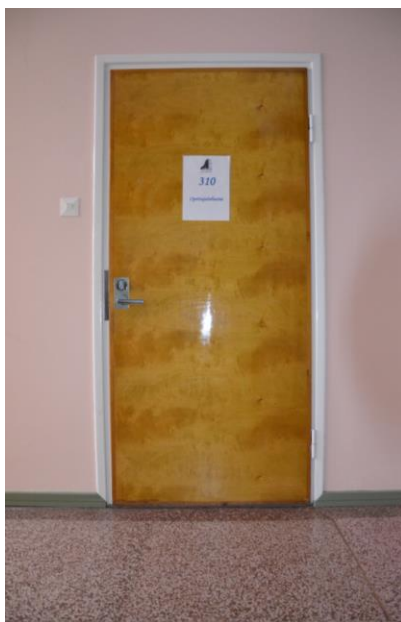
Vanhemmassa siipiosassa on säilynyt luokissa vanha, mahdollisesti alkuperäinen koivuparketti. Oikealla lakattu vaneriovi, lattialista ja mosaiikkibetonilattiaa.
