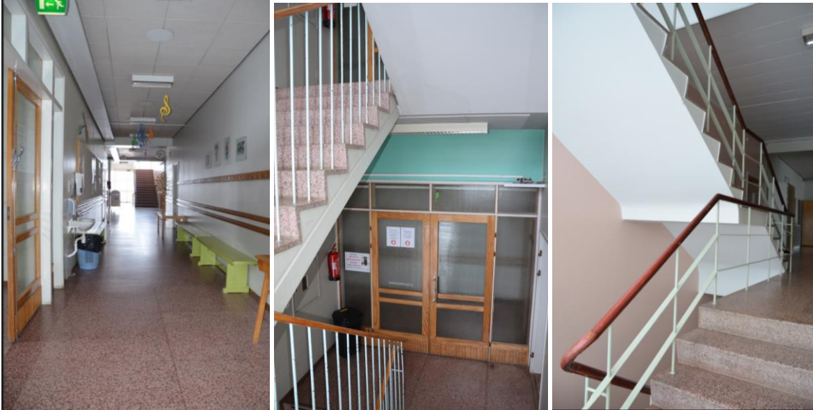
Käytäviä, ovia ja porrashuoneita.
