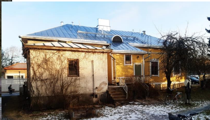
Pihajulkisivu, etualalla näkyvän laajennuksen aumakatto ympäröivästäineen noudattaa rakennuksen kattomuotoa ja kaltevuutta. Rapatun laajennusosan lisäksi 1950-lukua edustavat terassi, portaat ja niiden metallikaiteet. Vanhasta keittiökuistista on poistettu toinen ovi.
