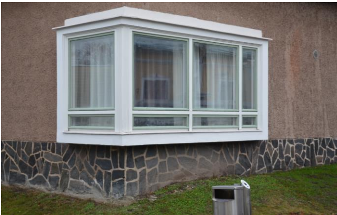
Asuinsiiven nurkkaikkuna ja eteläpäätty. Vintinpäädissä on käytetty ajalle tyypillisiä, vanhempaan rakentamiseen viittaavia kiilaikkunoita. Erkkeri kunnostettiin 2010-luvulla.
