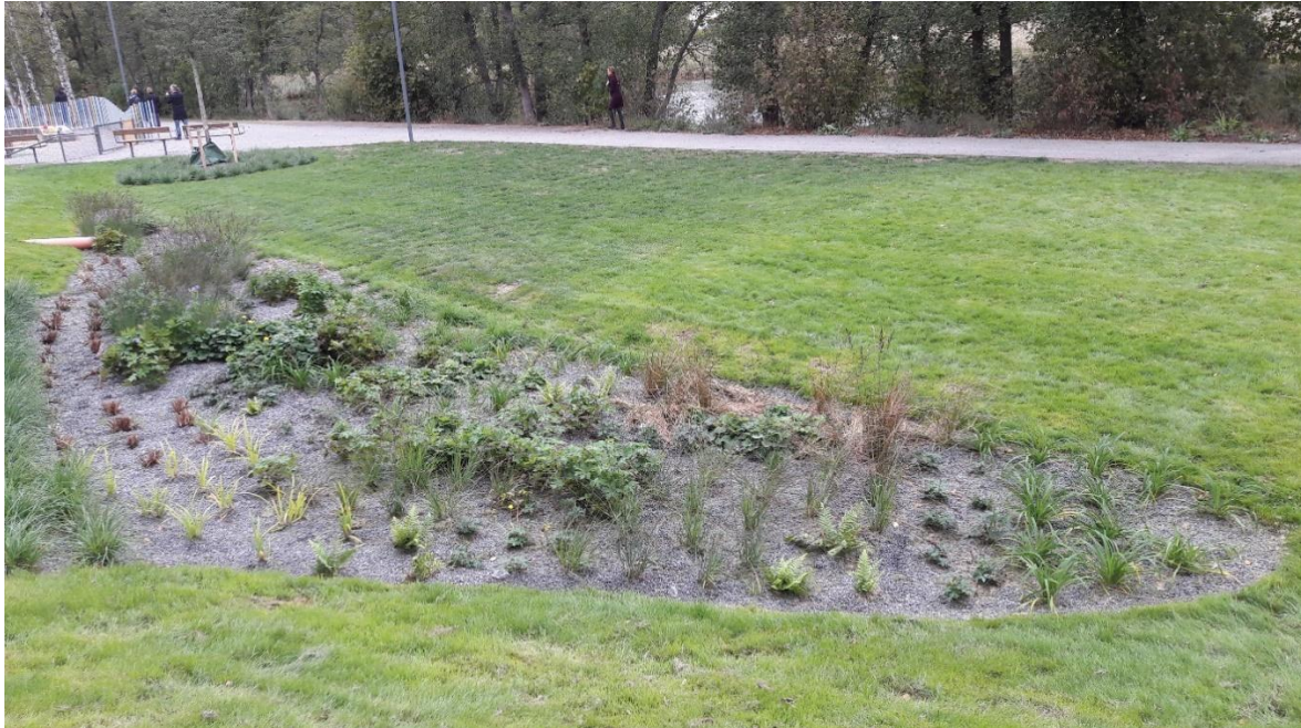
Kuva 4-2 Esimerkki hulevesien biosuodatuskentästä kerrostaloalueella Tukholmassa. Vedet johdetaan kuvan rakenteen pinnalle tulevalla purkuputkella suodatettavaksi. Biosuodatusalueella tarkoitetaan kasvipeitteellistä aluetta, jonka maakerroksina käytetään haitta-aineita suodattavia ja pidättäviä kerroksia. Alin kerros voi olla salaojallinen tai salaojaton riippuen halutaanko vedet imeyttää maahan vai johtaa alueelta eteenpäin.
