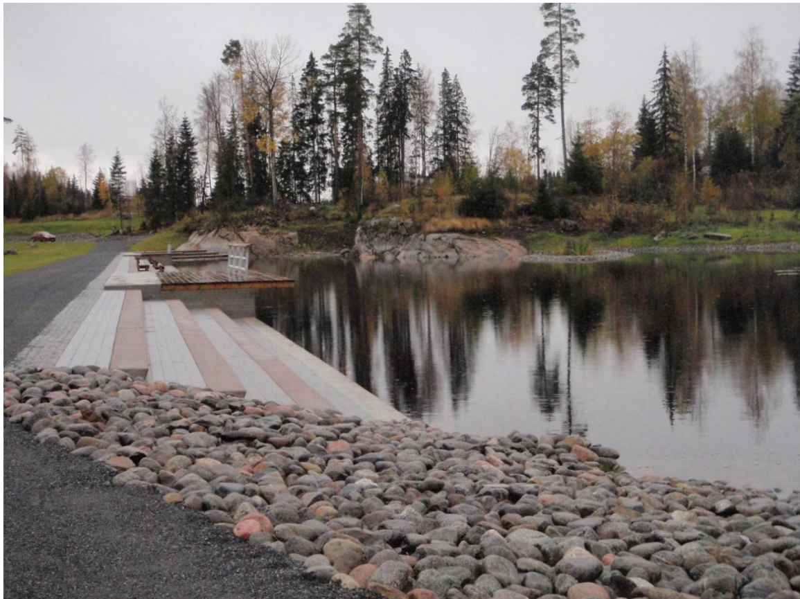
Kuva 4-2 Esimerkki laskeutusaltaasta Tampereelta. Hulevesien laskeutusaltaan on tarkoituksena pidättää hulevesissä olevaa kiintoainesta ja kiintoainekseen sitoutuneita haitta-aineita, kuten fosforia ja metalleja. Samalla allas toimii vesiä viivyttävänä, sillä altaaseen tarvitaan riittävä veden viipymä kiintoaineen laskeuttamiseksi. Altaan toimivuudelle on tärkeää, että se on tarpeeksi syvä ja muotoilu on oikeanlainen.
