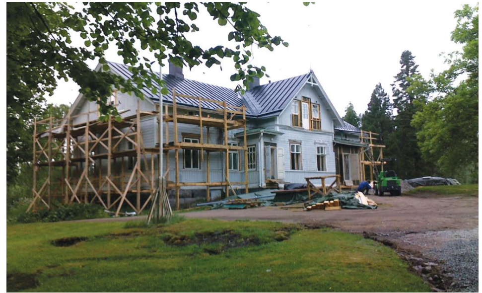
Kuva 21. Vanha-Lahden kartanon päärakennusta remontoidaan.
