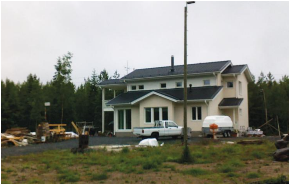
Kuva 23. Latokarintien päässä sijaitseva kesällä 2011 rakenteilla ollut omakotitalo.
