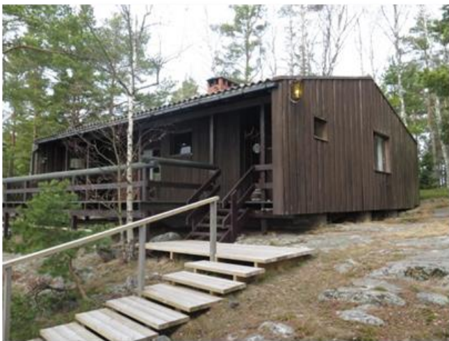
Joitakin rakennuksia paranneltiin ja osittain myös uusittiin vuosien varrella. Kuvassa vuonna 1962 hyväksytty piirustus saunan tilalle valmistuvalle huvilalle huvilapalstalla nro 4. Kyseisen palstan rakennukset on purettu 2000-luvun alussa. Alakuvassa palstan 8 vuonna 1972 rakennettu uusi sauna.
