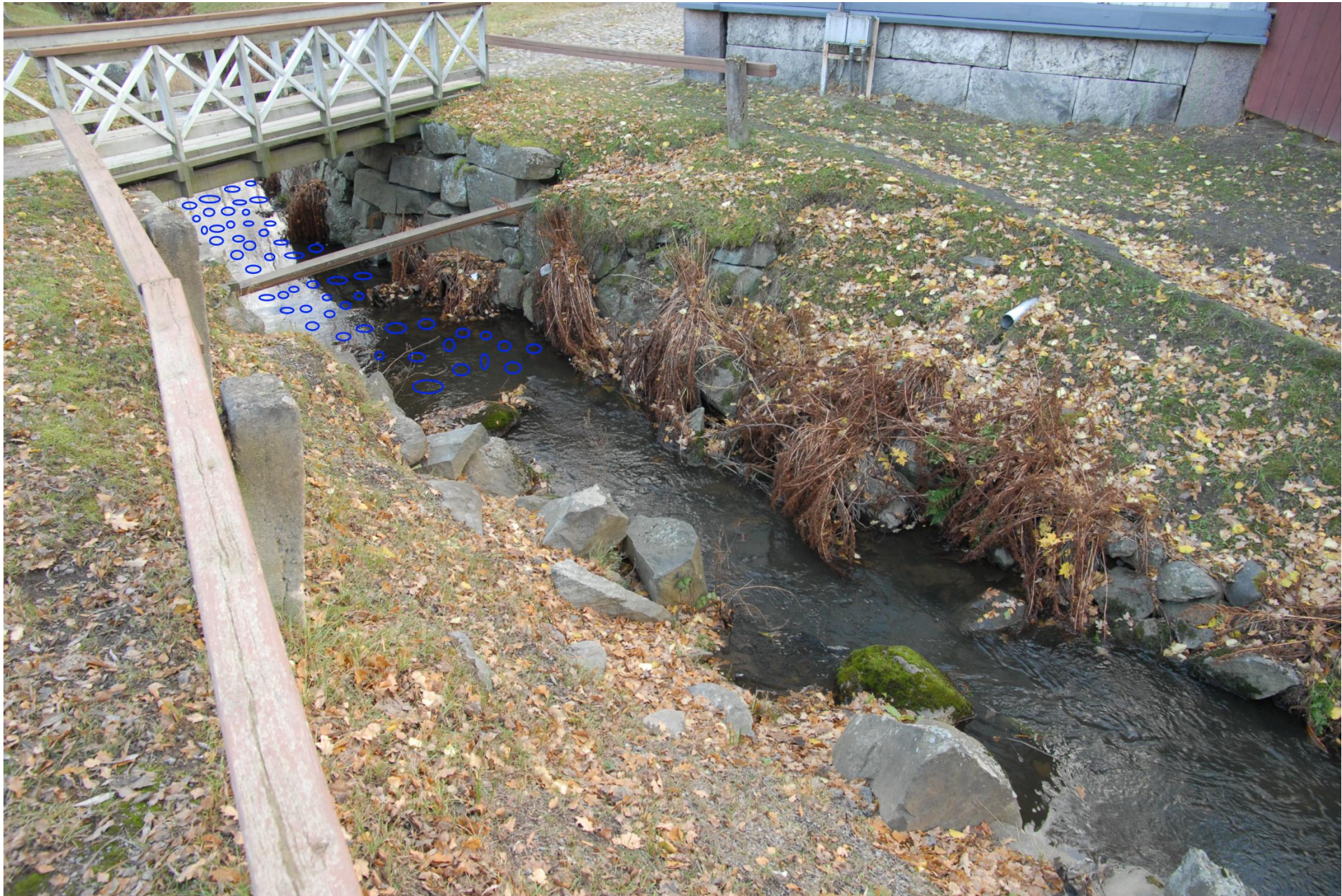
Kuva 10. Taarinsillan alle perustetaan kutusoraikko.
