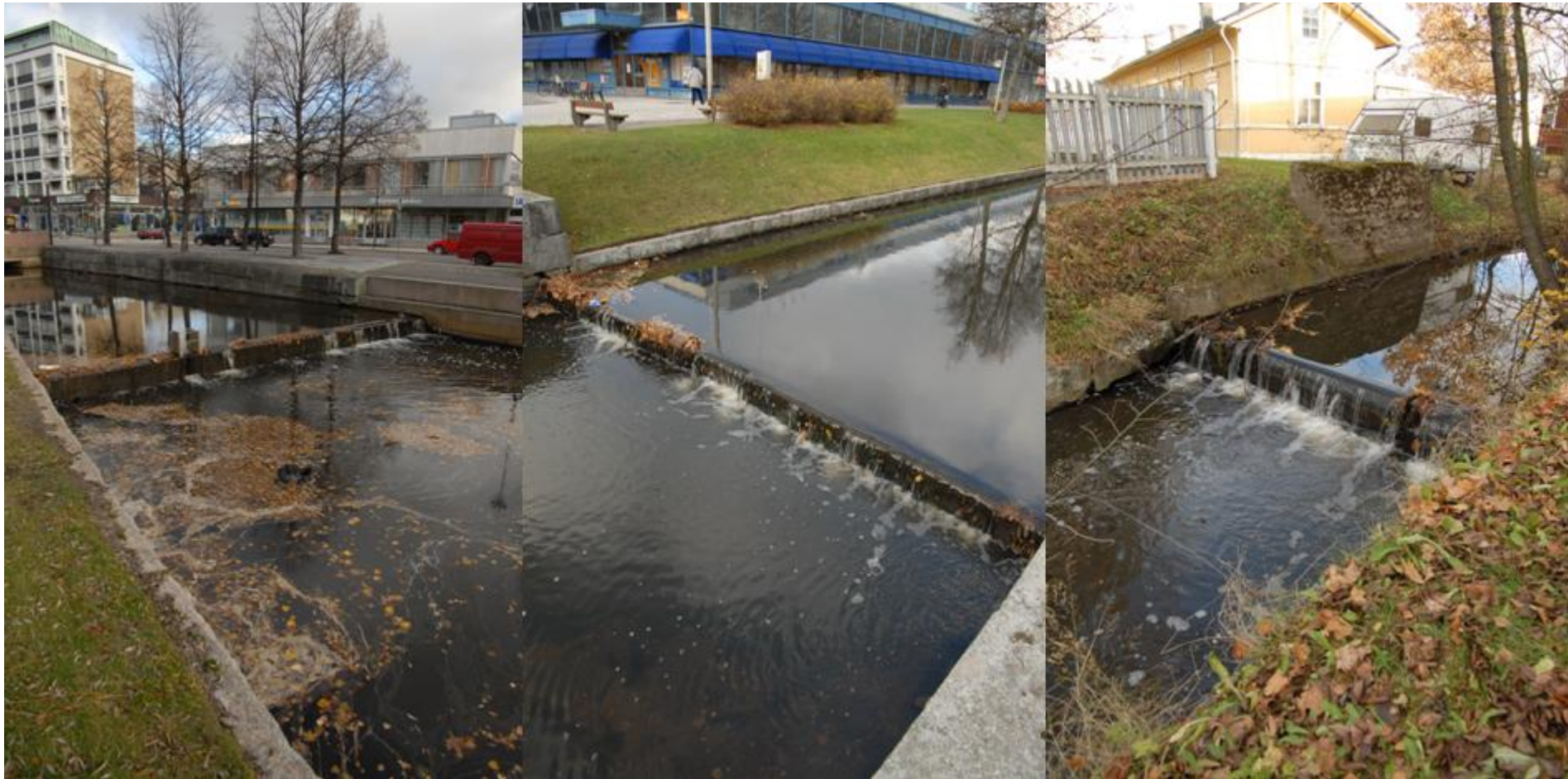
Kuva 20. Raumanjoen alaosan patorakenteet kuvattuna siten, että vasemmalla on alimmainen pato, keskellä keskimäinen ja oikealla ylimmäinen.
