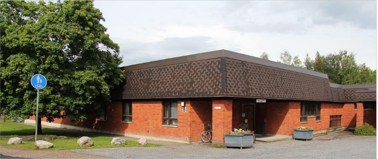
Koulun ulospäin näkyvin arkkitehtoninen erikoisuus on sen katto, jonka reunat ovat aumatut. Kuvassa rakennuksen kirjastoosaa. Kuva Pekka Piiparinen (2014)
