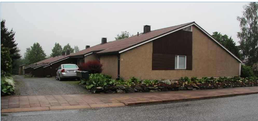
Luostarinkadulla on viisi 1960-luvulla valmistunutta rivitaloa, joiden värimaailma sopeutuu edellisen vuosikymmenen aikana valmistuneisiin omakotitaloihin. Kuva Pekka Piiparinen (2014)
