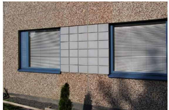
As Oy Meritavin (1976) julkisivuja on elävöitetty ikkunoiden välisten alueiden toteuttamisella keraamisilla laatoilla. Kuva Pekka Piiparinen (2014)
