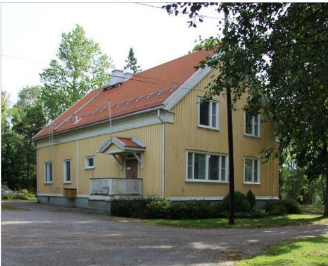
Kivelä on tätä nykyä RaumaCellin käytössä. Rakennus on valmistunut 1930-luvulla virkailijaperheiden asuinkäyttöön. Kuva Pekka Piiparinen (2014)
