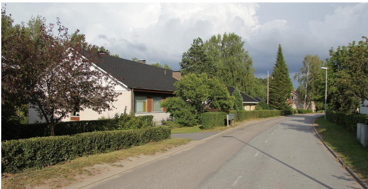
Polttimonkadulla on rakennuksia 1950-, 1960- ja 1970-luvuilta. Eri vuosikymmenien rakennuskanta on sopeutunut melko yhtenäiseksi aluekokonaisuudeksi. Kuva Pekka Piiparinen (2014)
