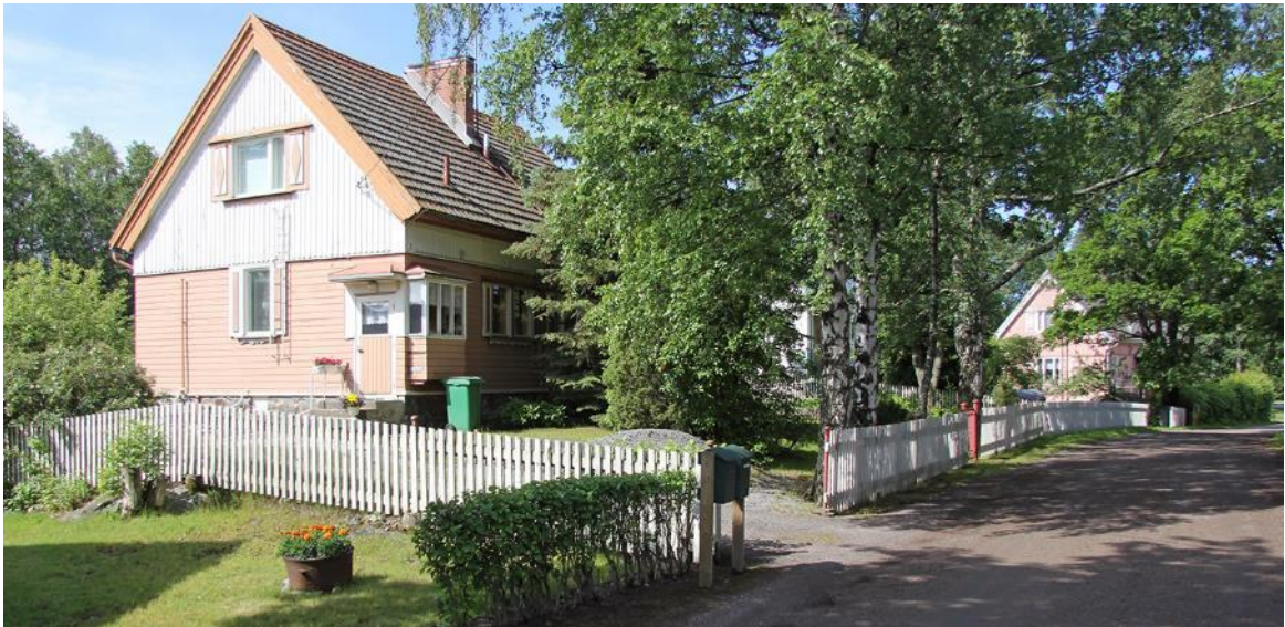
Kompin rakennuksia on muutettu vuosikymmenien aikana toistensa kaltaisista tyyppitaloista kohti yksilöllisiä omakotitaloja. Muutokset eivät ole olleet niin radikaaleja, etteikö rakennuskannasta voisi tunnistaa alueen yhtenäistä ilmettä. Kuva Pekka Piiparinen (2014)
