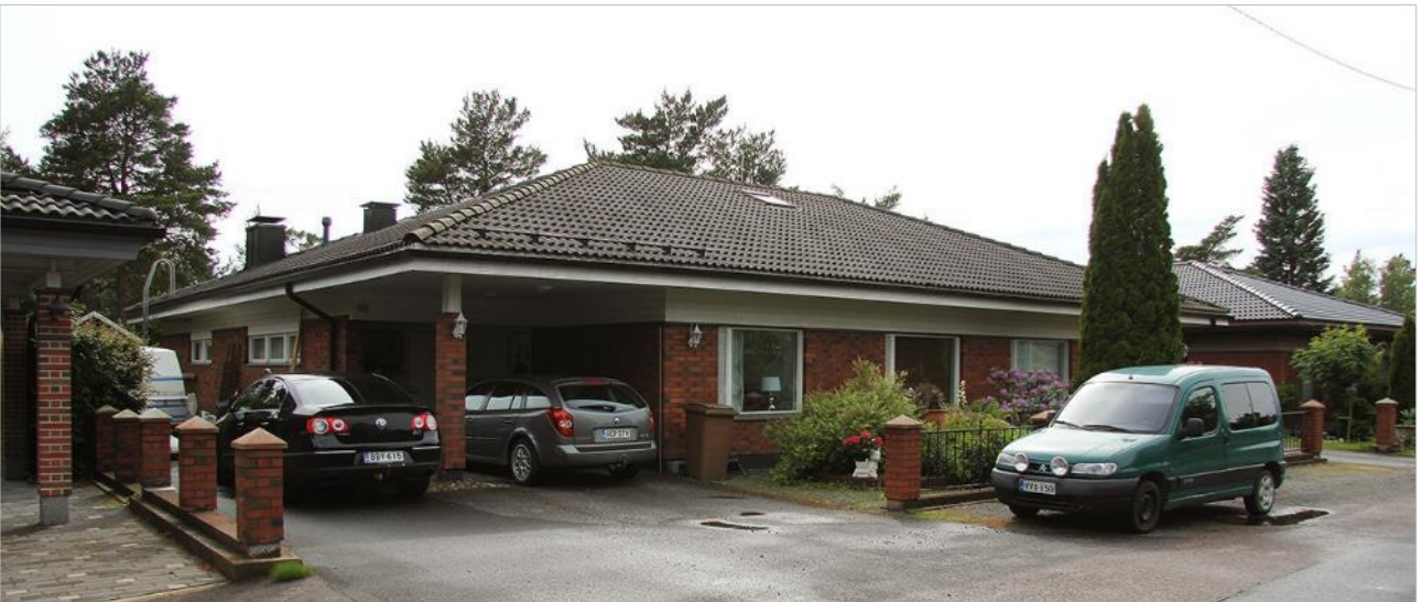
Useat alueen omakotitalojen katoista on aumattu. Kuva Pekka Piiparinen (2014)
