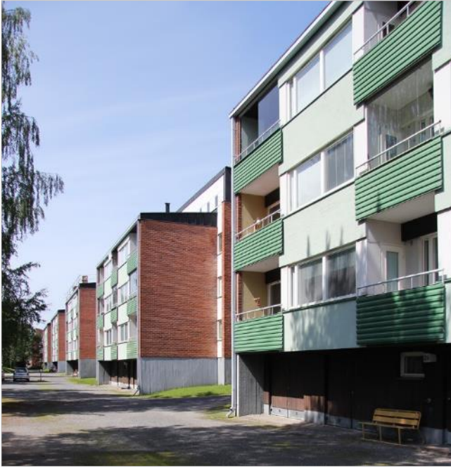
Eero Karin suunnittelemien kohteiden pihan puolta. Parvekkeiden eteen toteutetut profiloitunut pellit eivät liene alkuperäisiä. 201 Kuva Pekka Piiparinen (2014)
