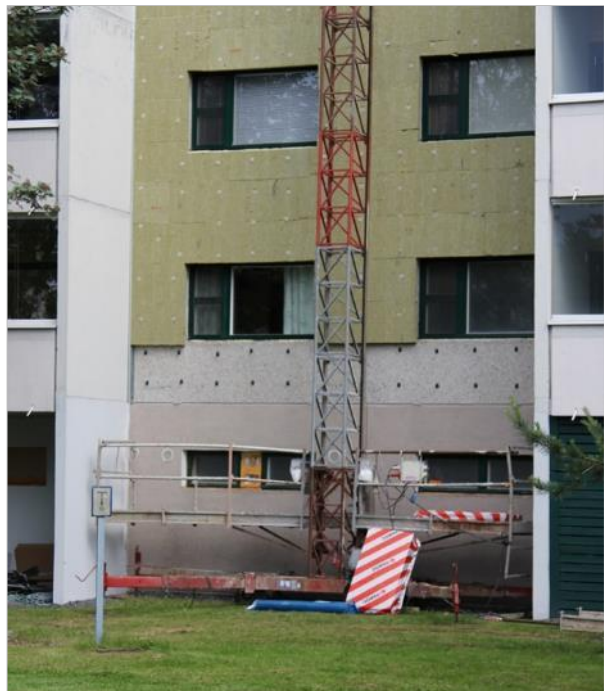
Sinisaaren yksi asuinkerrostalo oli julkisivusaneerauksen kohteena. Alkuperäisiä pesubetonielementtejä peitetään lisälämmöneristeellä. Kuva Pekka Piiparinen (2014)
