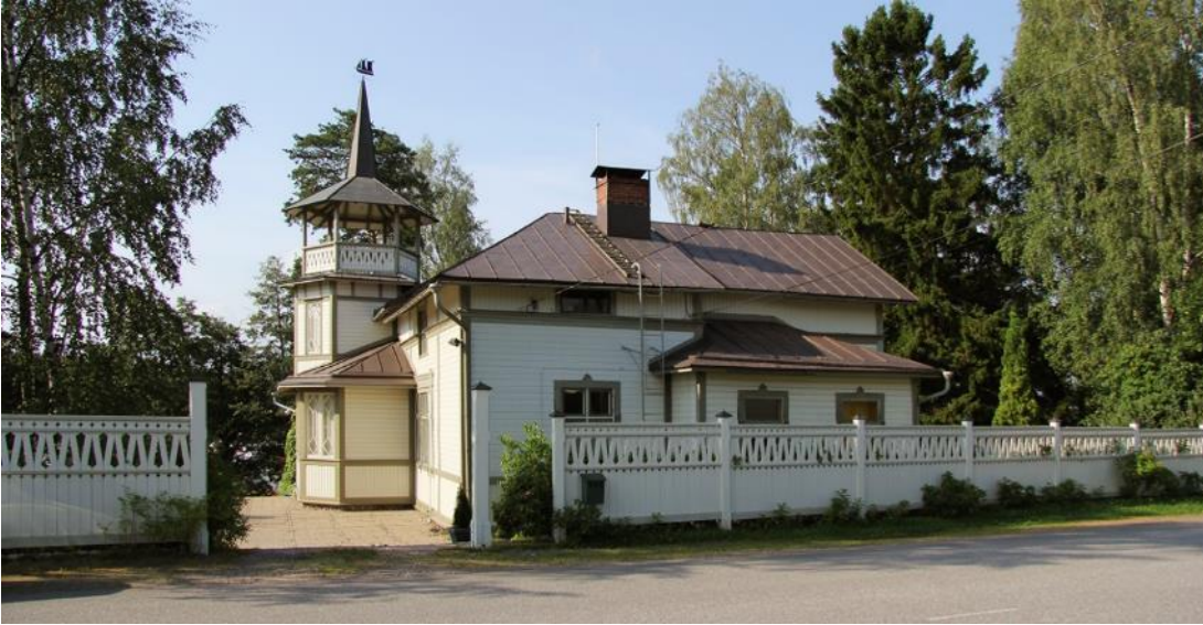
Vilhola on rovasti Vilho Kaitilan vuonna 1892 rakennuttama huvila. Rakennus edustaa alueen alkuperäistä vapaasti sijoittunutta ranta-asutusta. 130 Kuva Pekka Piiparinen (2014)
