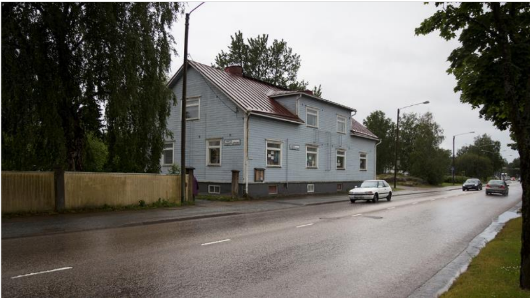
Aittakarinkatu 8 on valmistunut todennäköisesti 1930-luvulla ja tunnetaan nimellä "Korten koulu". Kuva Pekka Piiparinen (2014)
