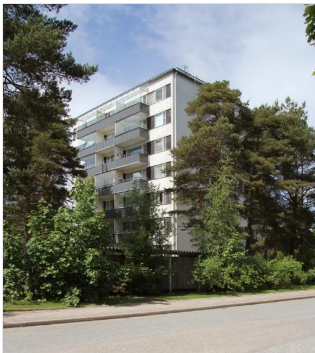
Yksi alueen kerrostaloista on vuorattu peltilevyin. Kuva Pekka Piiparinen (2014)
