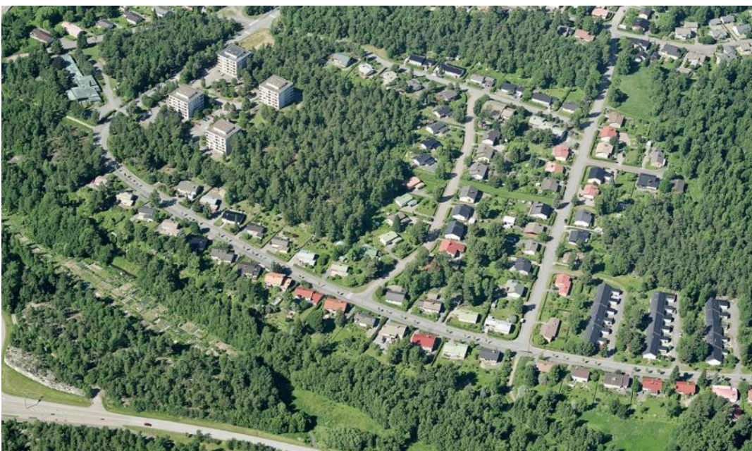
Paroalhon eteläosa muodostaa pitkälle yhtenäisen 1960-luvulla toteutetun kokonaisuuden. Maakunnallisesti merkittäväksi alueeksi on kuitenkin määritelty vain Hiuknummentien, Pähkinäpolun ja Lehtokadun muodostama kokonaisuus. Kuva © 2011 Blom
