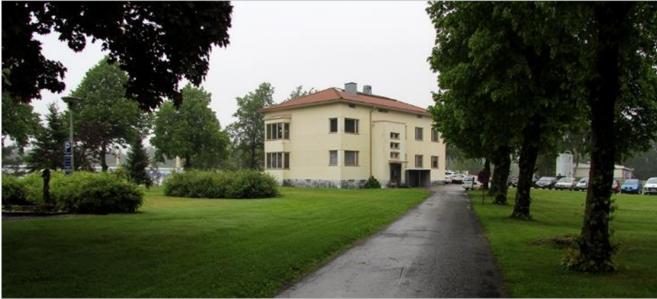
Entinen lääkäreiden asuinrakennus on valmistunut 1950-luvun alkupuoliskolla ja sen on suunnitellut Arkkitehti Bertel Strömmer. Kuva Pekka Piiparinen (2014)
