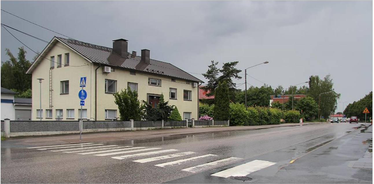
Yksi alueen rakennuksista sijaitsee Lensunkadun eteläpuolella. Rakennus on valmistunut vuonna 1956. 262 Kuva Pekka Piiparinen (2014)
