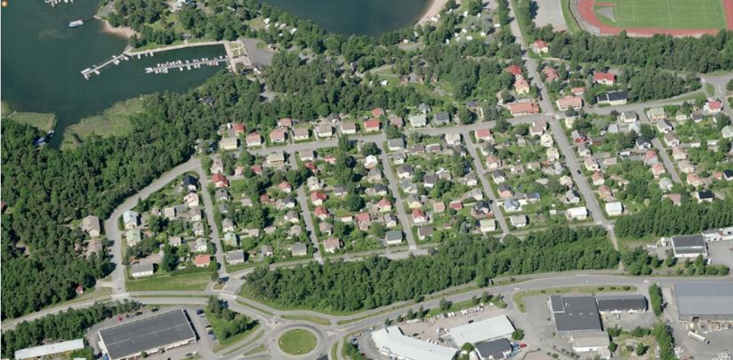
Rauman kaupunkirakenteessa Pidesluodon alue rajautuu selkeästi omaksi kokonaisuudekseen. Sen sijainti on otollinen kaupungin keskustan, meren ja liikunta-alueiden läheisyydessä. Kuva © 2011 Blom
