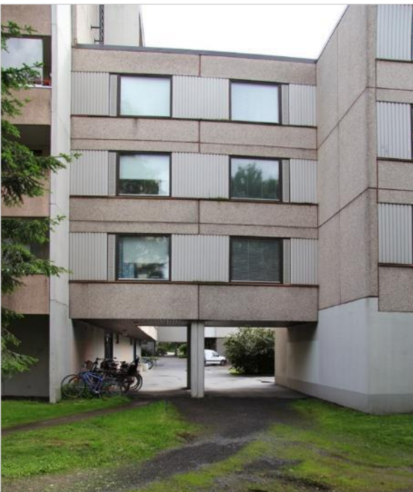
Sinisaaren yksi asuinkerrostalo oli julkisivusaneerauksen kohteena. Alkuperäisiä pesubetonielementtejä peitetään lisälämmöneristeellä. Kuva Pekka Piiparinen (2014)
