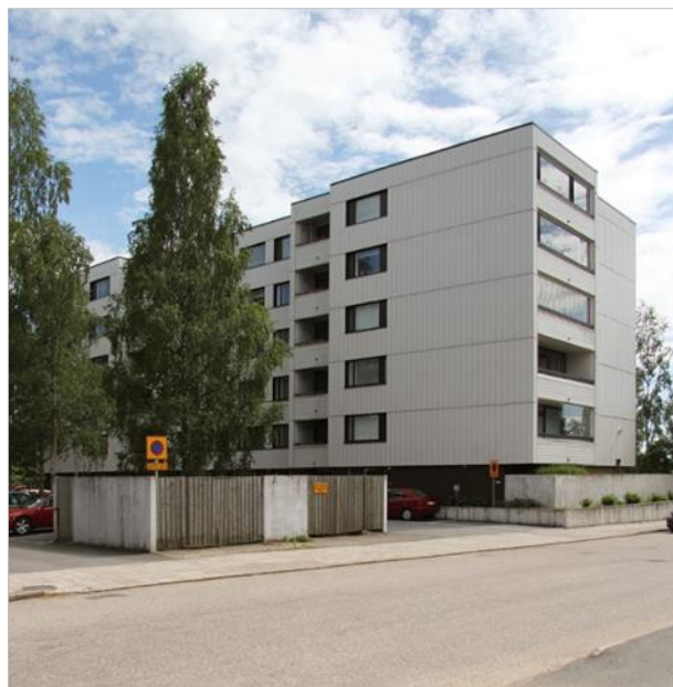
Alueen joidenkin rakennusten parvekkeita on lasitettu. Muuten rakennusten alkuperäisyys alueella on säilynyt melko hyvin. Kuva Pekka Piiparinen (2014)
