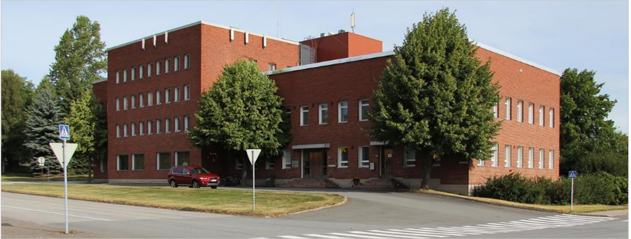
Rauman kaavoituksen paikkatietojen mukaan Rauman tehtaani entinen konttorirakennus olisi valmistunut 1930-luvulla. Kuva Pekka Piiparinen (2014)
