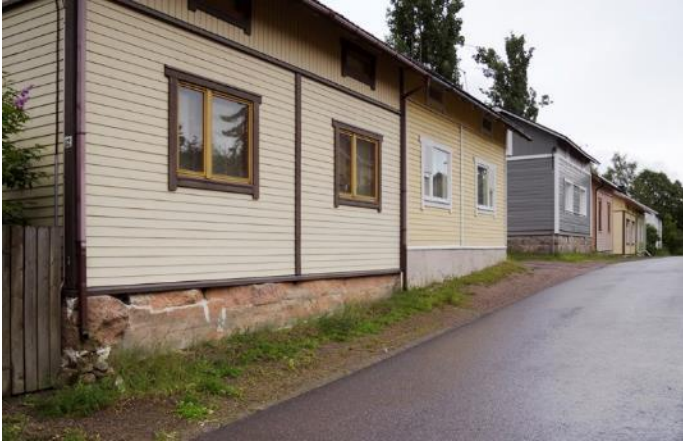
Perämiehenkatua. Kuvassa oikealla kaksi rakennusta on liitetty toisiinsa tai talon laajennus on toteutettu vanhasta poikkeavalla tavalla. Vastaavia kohteita on myös Konepajankadulla. Kuva Pekka Piiparinen (2014)
