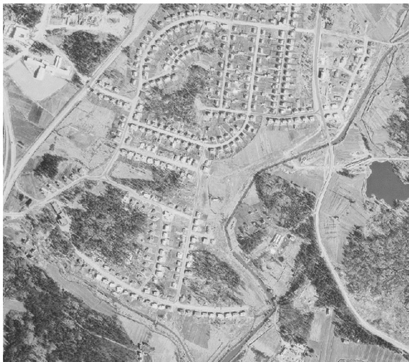
Vuonna 1965 otetusta ilmakuvasta nähdään, miten Paroalhon eteläosan rakentaminen oli päässyt jo hyvin pitkälle. Kartta Rauman kaupungin karttapalvelu
