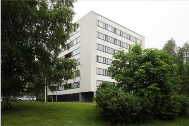
Tyypillisen Tornelankujan kerrostalon julkisivut on slammattu ja vuorattu asbestisementtilevyillä. Kuva Pekka Piiparinen (2014)
