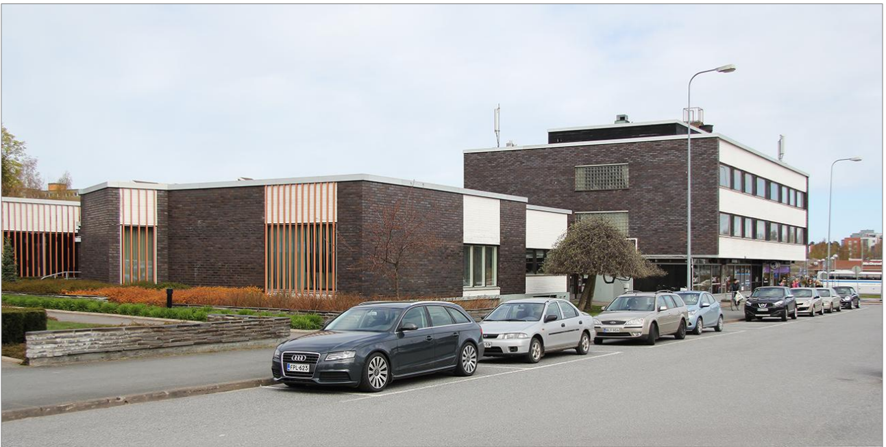
Modernia laadukasta hengellistä arkkitehtuuria edustaa kirkkoherranvirasto Kirkkokadun alkupäässä. Kuva Pekka Piiparinen (2014)
