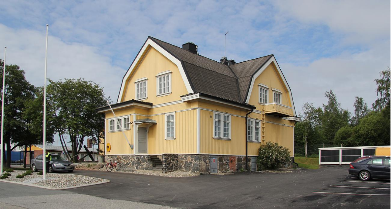
Entinen lasitehtaan konttorirakennus ja satamatoimisto on ulkoisesti hyvässä kunnossa. Kuva Pekka Piiparinen (2014)
