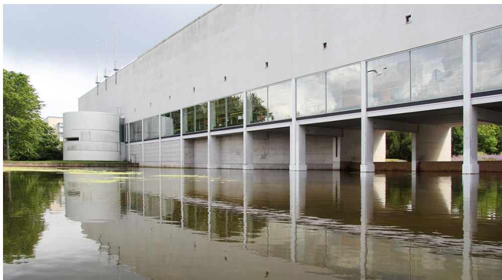
Valtion virastotalo on yksi Rauman modernin julkisen rakentamisen laadukkaimmista edustajista. Pekka Piipari- nen (2014)
