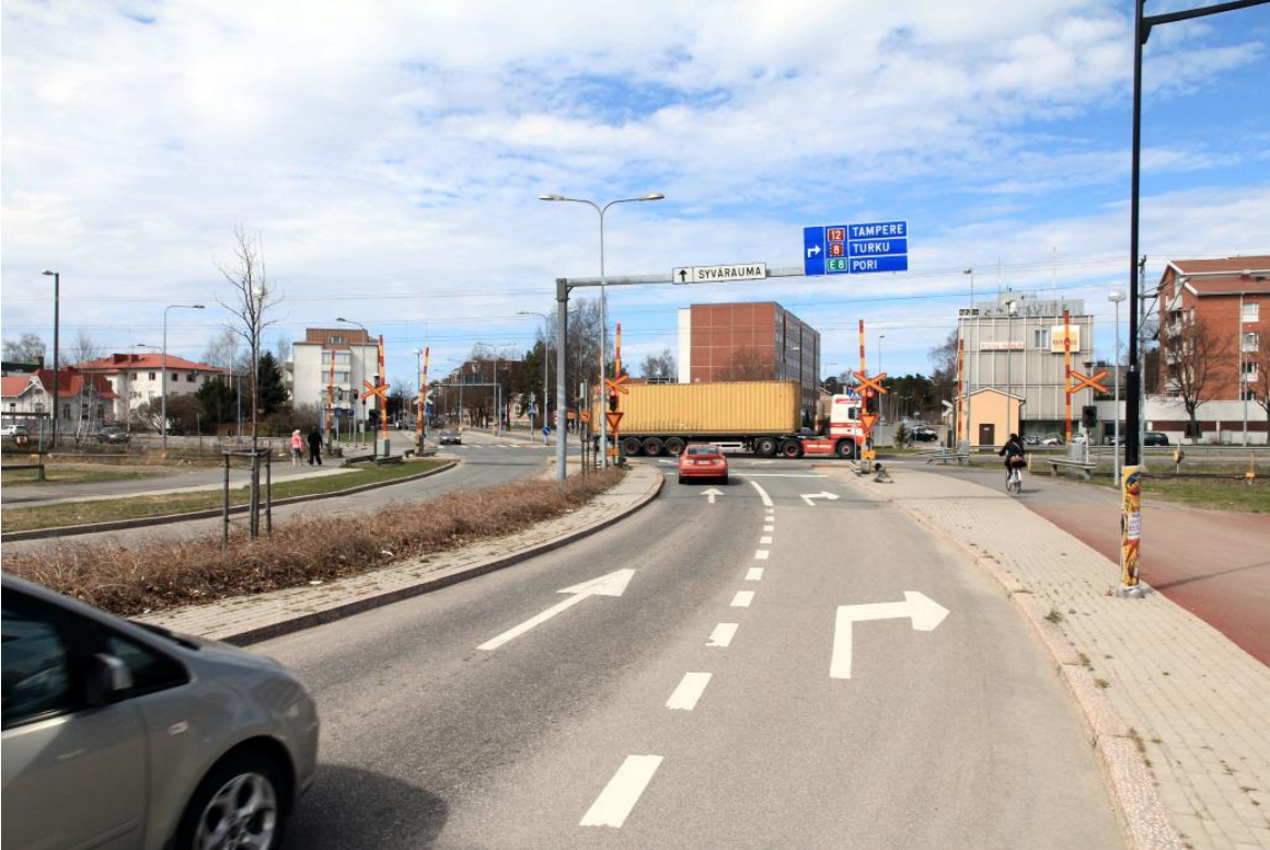
Kuva 30. Valtakadun tasoristeys. Molemmin puolin tasoristeystä on kevyen liikenteen väylät. Liikennevalojen sijoitus on liittymäalueen vuoksi tavanomaisesta poikkeava.
