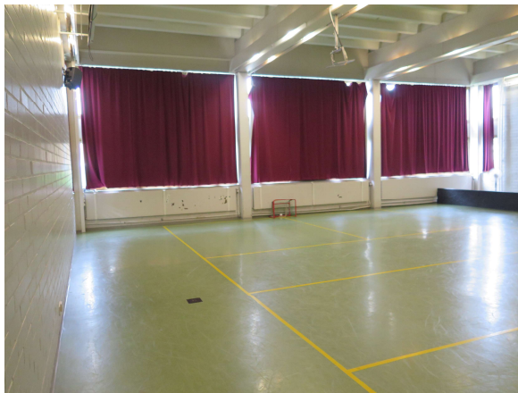
Luento-/ liikuntasalissa lattiapäällyste on vaihdettu.
