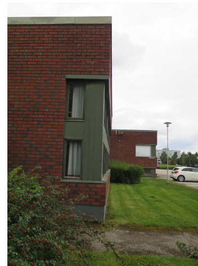
Yllä kuva paloaseman sisäänvedetyistä ja alkuperäisistä ikkunoista sekä ikkunoiden väliin asennetusta profiloitusta alumiinilevystä. Alla kuva alkuperäisistä ovista: pääsisäänkäynti (vas.) ja kalustohallin nosto-ovi (oik.).
