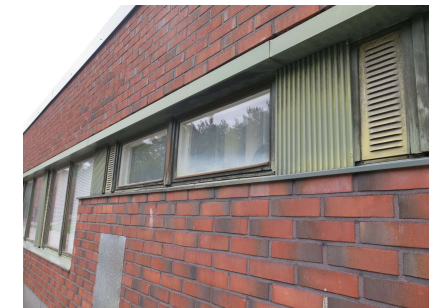
Yllä kuva paloaseman sisäänvedetyistä ja alkuperäisistä ikkunoista sekä ikkunoiden väliin asennetusta profiloitusta alumiinilevystä. Alla kuva alkuperäisistä ovista: pääsisäänkäynti (vas.) ja kalustohallin nosto-ovi (oik.).
