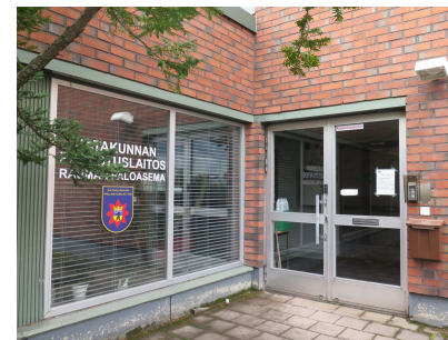
Yllä kuva paloaseman sisäänvedetyistä ja alkuperäisistä ikkunoista sekä ikkunoiden väliin asennetusta profiloitusta alumiinilevystä. Alla kuva alkuperäisistä ovista: pääsisäänkäynti (vas.) ja kalustohallin nosto-ovi (oik.).
