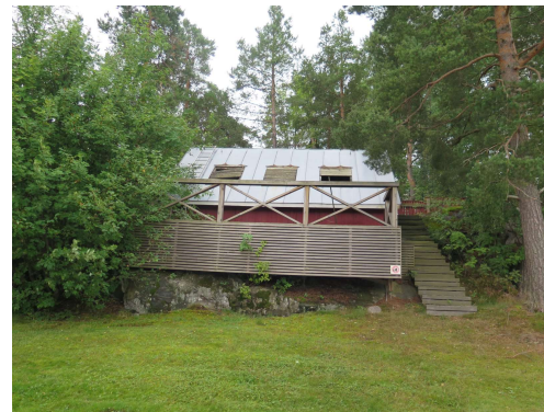
Yllä harjoituskatoksen julkisivu pohjoisesta.
