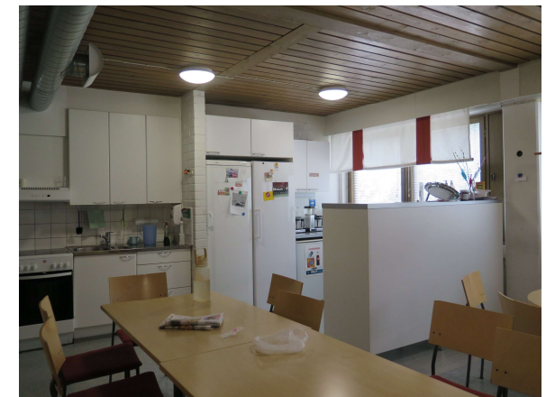
Miehistön keittiön sisäkatoissa on alkuperäinen lautapanelointi.
