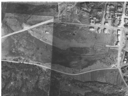
Ilmakuva vuodelta 1940, jossa alue on pitkälti rakentamaton. Paloasema on kuvassa alhaalla keskellä, tien ja peltoalueen välissä. (Kuva: Rauman kaupungin karttapalvelu, ilmakuva 1940)
