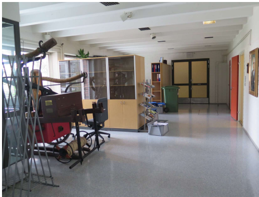
Teräsbetonelementti katto on näkyvässä sisääntuloaulassa (yllä). Portaikossa (oik.) ajalle tyypillinen käsijohde.
