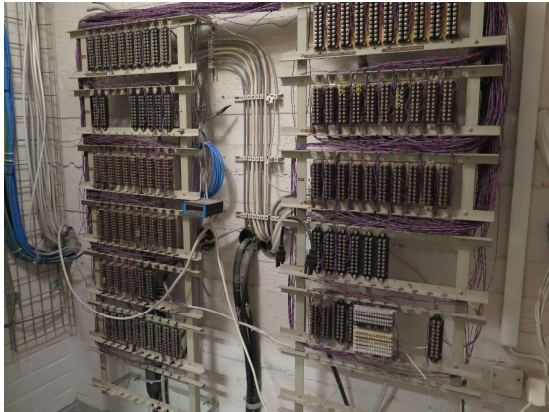
Alla talojakamossa sijaitseva puhelinristikytentälaite.
