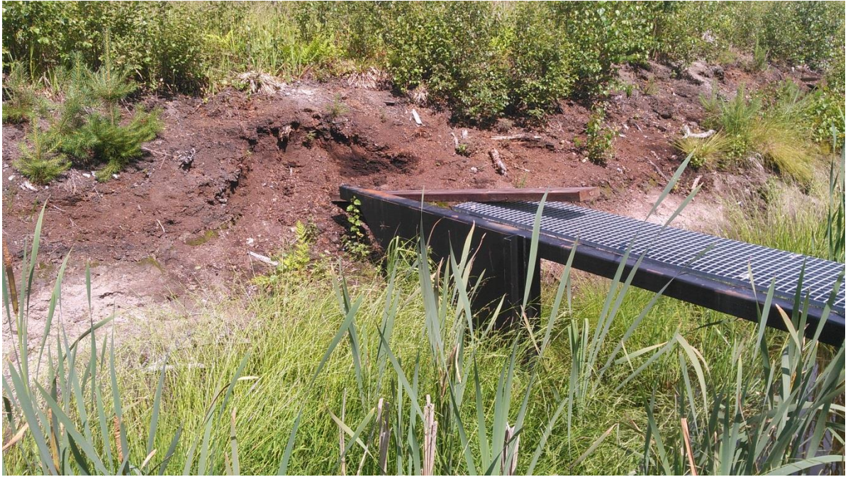
Kuva 2.5: Settipadon ympäri käyvä virtaus on syövyttänyt luiskaa.
