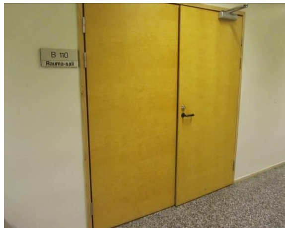
1. kerroksen sisäänkäynti auditorioon
