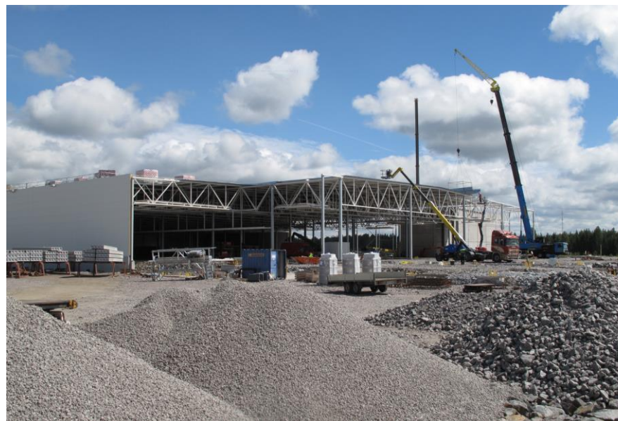
HKScanin rakennustyömaa Lakarin alueella kesällä 2016
