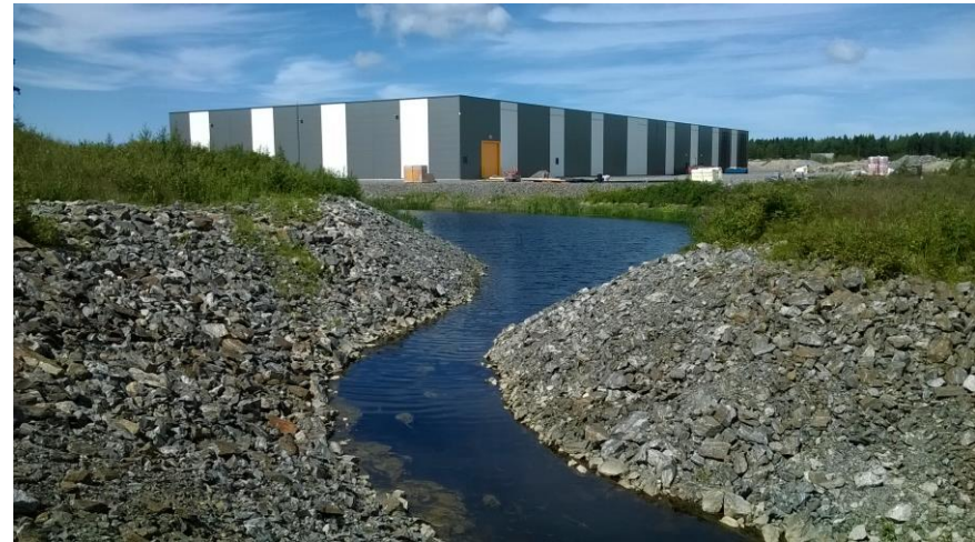
Kuvassa Lakarin alueelle rakennettu hulevesireitti
