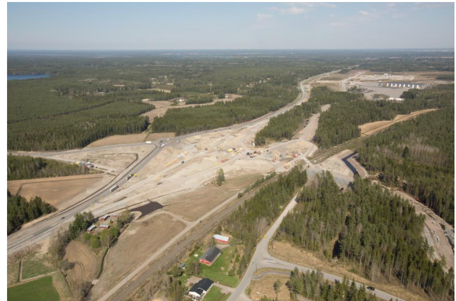
Luostarinkylän eritasoliittymän rakennustyömaa, kevät 2016
