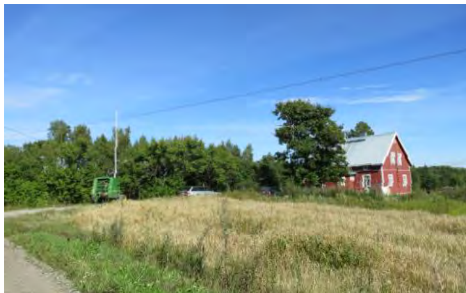
6. Vanhaa rakennuskantaa Taka-alhontien varressa.
