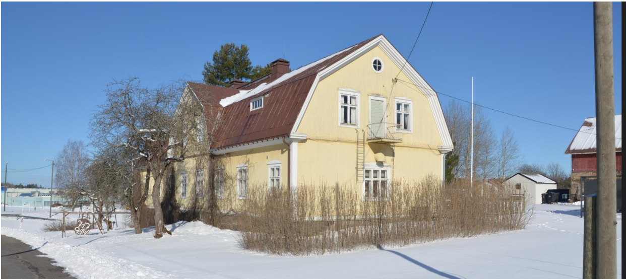
Pyörnin entinen kunnalliskoti kaakosta, oikealla vilja-aitta ja navetta.
