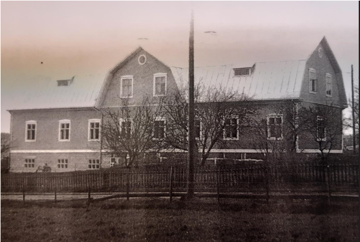
Pyörni kunnalliskodiksi muutettuna vuonna 1928. Etualalla näkyy maantie, tonttia rajaa säleaita. Kuvassa näkyy vasemmalla hyvin rakennuksen jatkaminen, sen sokkeli muurattiin betonitiilestä. Kuva: T.Vahalan kokoelma, Pyörnin talon arkisto.
