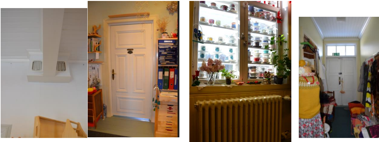
Alkuperäistä kiinteää sisustusta, vasemmalla korvausilman venttiileitä, välistä on purettu seinä. Nelipeilinen ovi, radiaattori ja ikkuna, oikealla toinen talossa käytetty ovimalli, kolmipeilinen.
