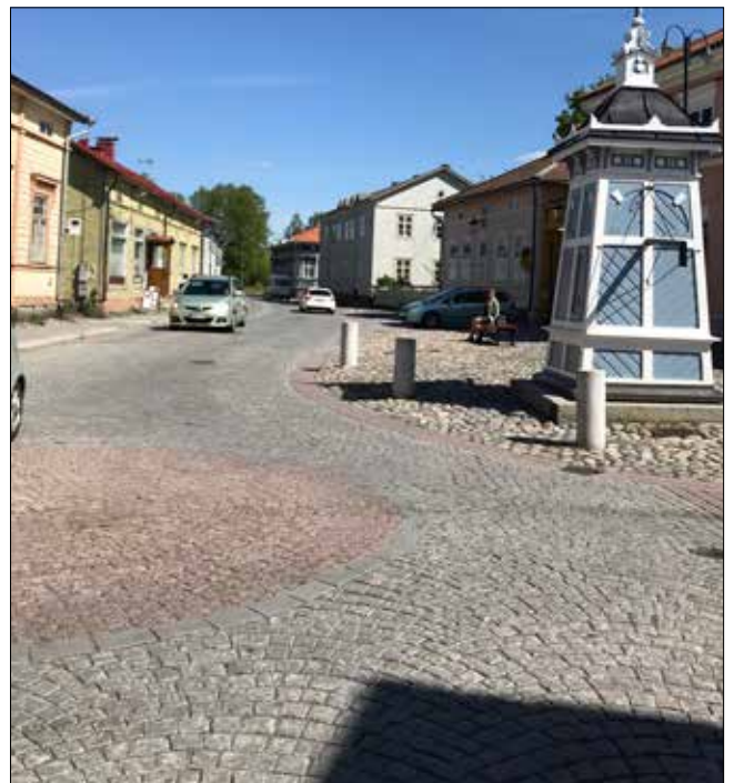
Hauenguanon toria kesällä 2020. Uusitun pinnan materiaalivalinta on onnistunut, mutta verrattuna historiallisiin kuviin kirjava kivimateriaali risteuksen keskellä olevine ympyröineen antaa aikaisempaan verrattuna hieman sekavan kuvan. Taidemuseon ja kaivon edusta, ajotiet ja kävelykadut ovat selkeästi erotettu toisistaan.
