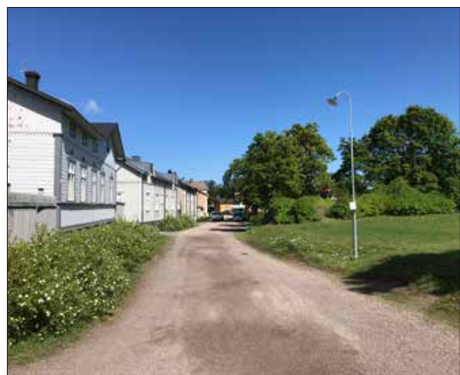
Sorapintaisen Tullivaheen melko perinteistä näkymää, vaikka tien itäpuoli onkin muuttunut aikojen saatossa merkittävästi.
