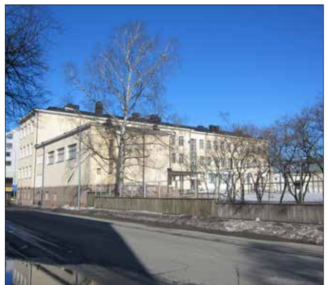
Koulun piha-alueita rajaavat iäkkäämmiltä osiltaan mahdollisesti 1950-luvulle ajoittuvat metalliaidat. Piha-alueen laajennus erottuu myös aidassa Nortamonkadun puolella. (Valokuva Olli Joukio 2013.)
