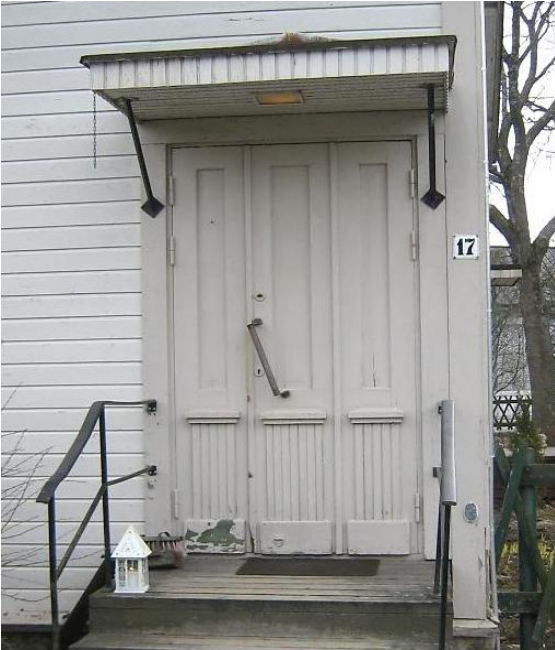
1940-luvun lopun sisäänkäynti on säilynyt vailla muutoksia. Kehysoven yläosa on varustettu peilein ja alaosaa verhoiltu koristepaneelilla.
