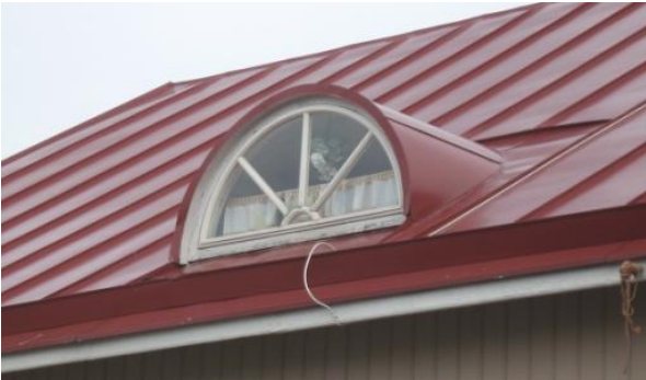
Perinteinen lunettikkattolyhty sijoittuu katonlappeen alaosaan.
