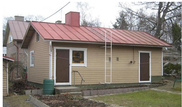
1950- ja 60-lukujen talousrakennukset ovat huomattavan leimallisia alueen rakennuskannassa.
