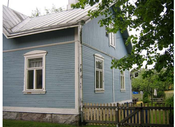
Alkuperäisen ulkokuorauksen säilyminen nostaa olennaisesti vanhan talon rakennushistoriallista arvoa.
