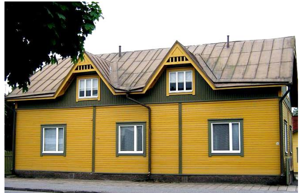
Nummen taloissa on säilynyt melko paljon vanhoja palapellistä saumattuja peltikatteita. Nämä antavat merkittävän lisänsä alueen kaupunkikuvaan. Vesikatteiden kunto on syytä tarkastaa säännöllisesti.
