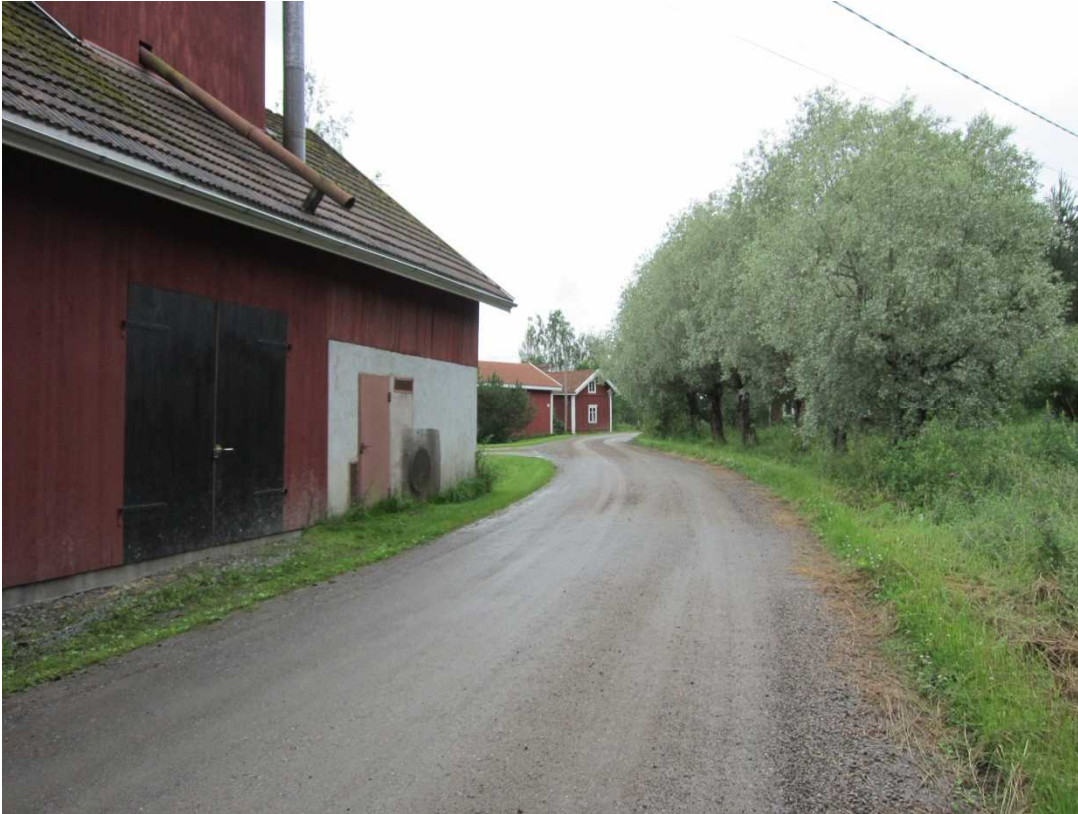
Yrjölän kantatilan rakennuksia. Kuva Olli Joukio.
