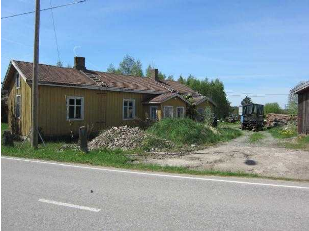
Merkittävä torppa-alue toimii nykyään lähinnä varastoalueena sekä erilaisten työkoneiden paikoitusalueena. Kuva Olli Joukio.
