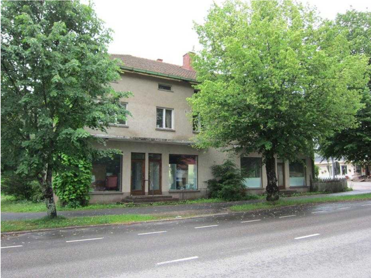
Hyvin säilynyttä rakennuskantaa uhkaa myös autoituminen. Kuva Olli Joukio.
