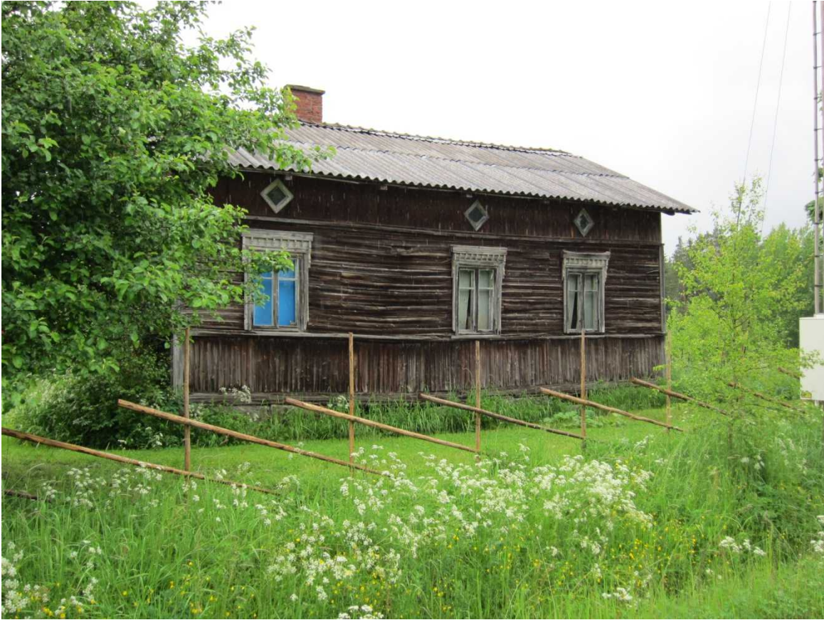
Pekomäen alueen vanhempaa rakennuskantaa. Kuva Olli Joukio.
