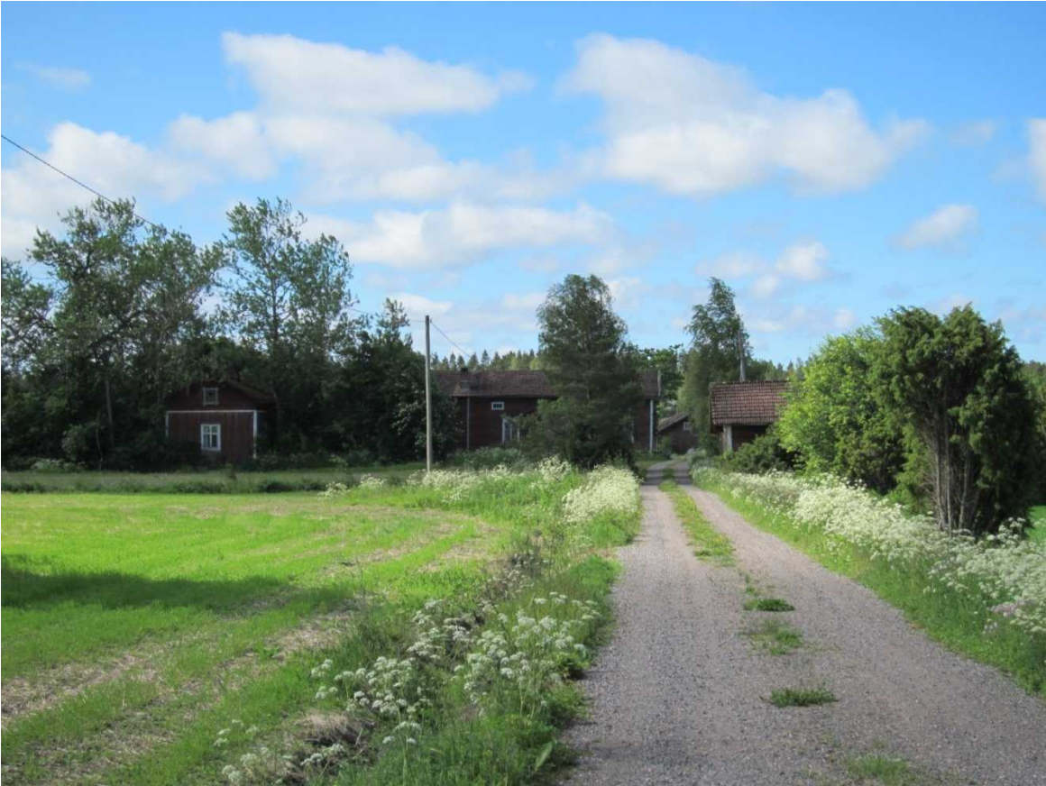
Helkkilän merkittävä rakennusryhmä peltoaukeiden keskellä. Kuva Olli Joukio.
