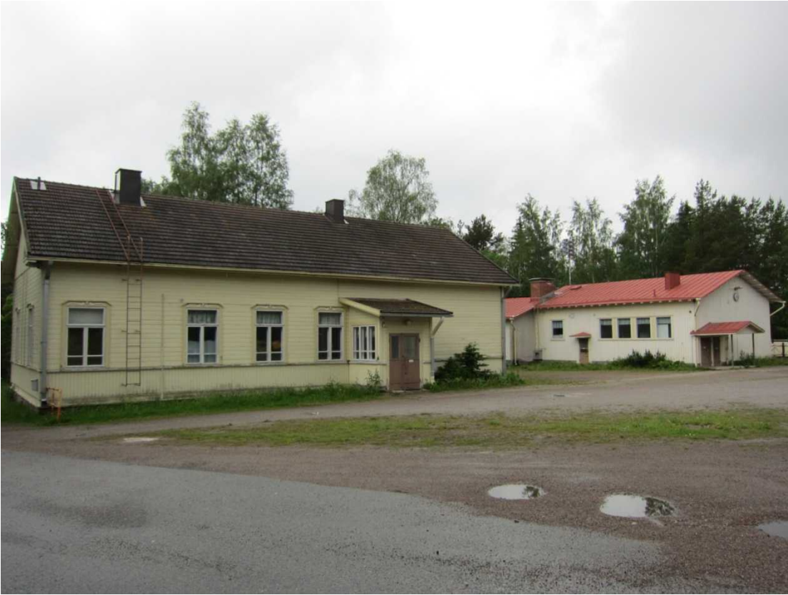
Vermuntilan 1910-luvulla valmistunut yläkansakoulu sekä 1960-luvun alussa valmistunut lisärakennus. Koulu lopetti toimintansa vuonna 2009.
