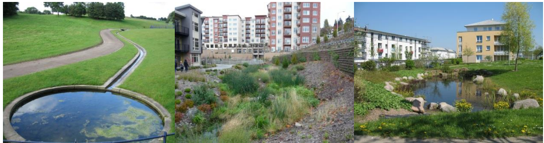
Kuva 27. Esimerkkejä painanteen rakentamisesta tiukemmin ja hallitummin.
