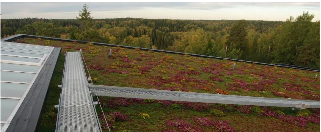
Kuva 21. Esimerkki laaja-alaisesta viherkatosta. Kohde Solvallon Urheiluopisto, Espoo 8
