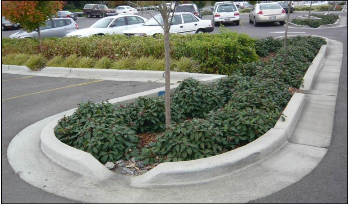
Kuva 23. Pysäköintialueen viherpainanne, jonne hulevedet ohjataan maanpinnalla reunakivien aukoista (Seattle). 8
