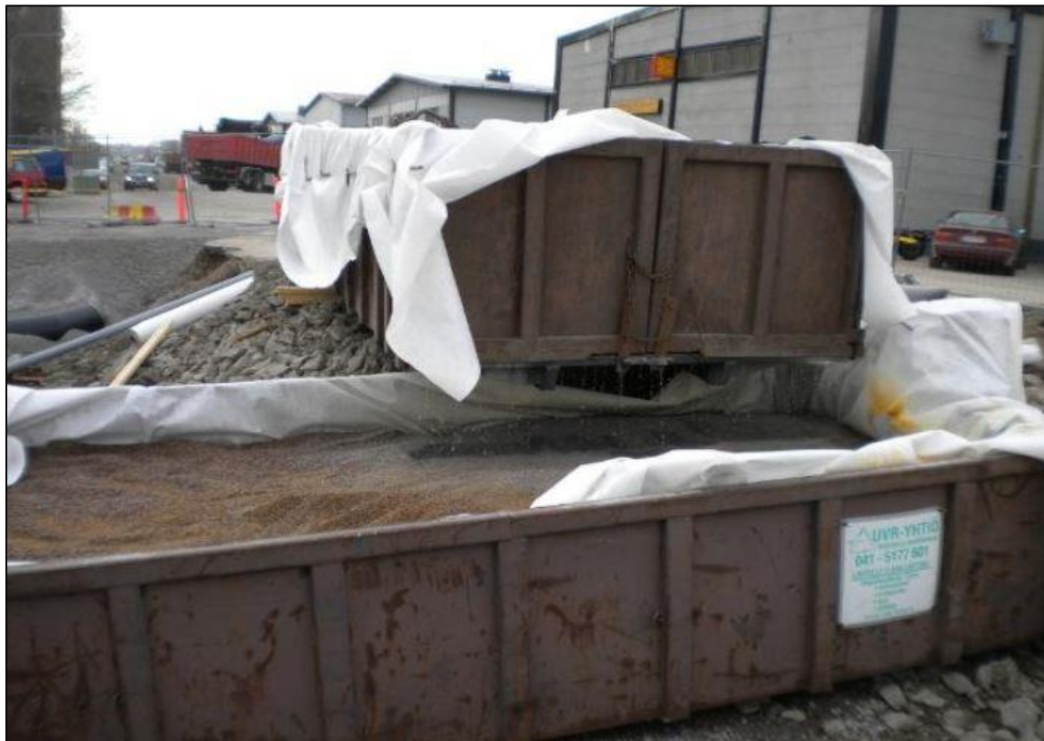
Kuva 34. Esimerkkikuva konttiselkeyttimestä. 20
