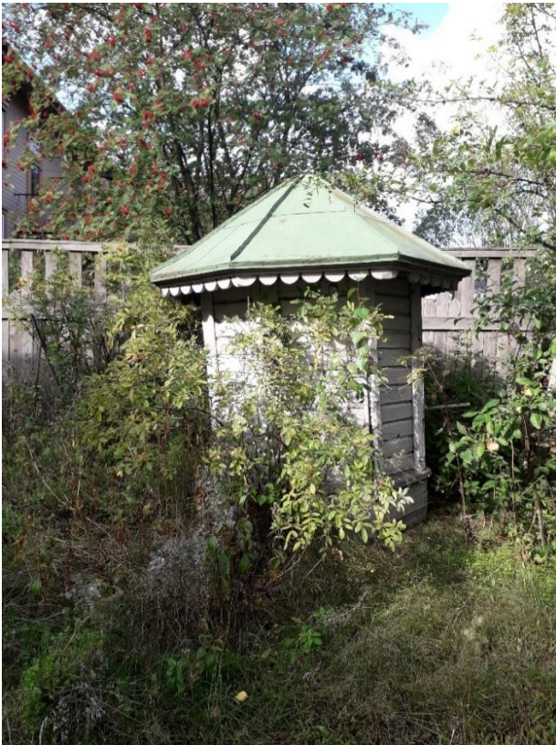
Valokuva tontilla 3 olevasta kaivokopista.
