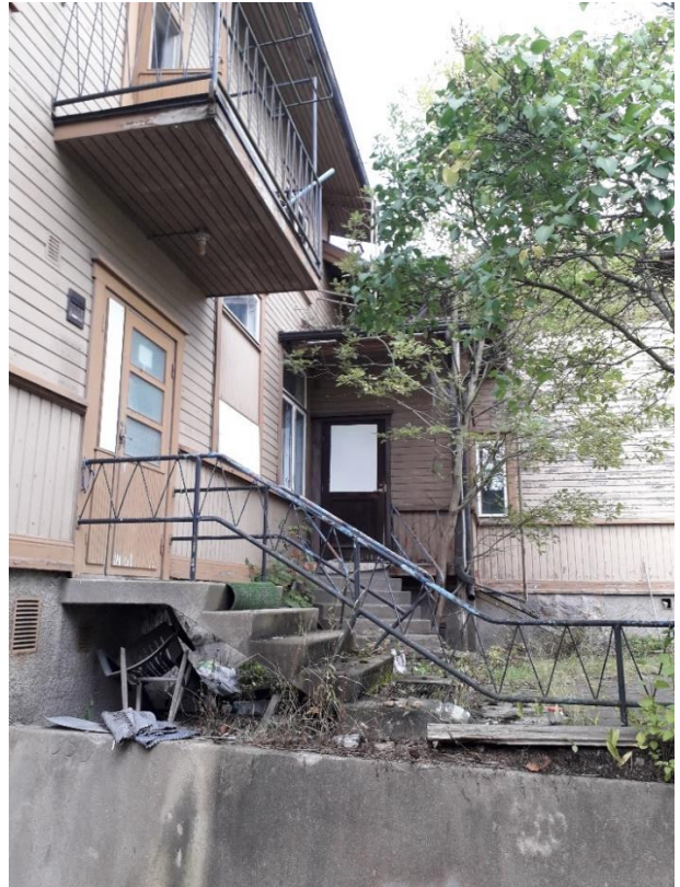
Valokuva pihan puolen julkisivusta.
