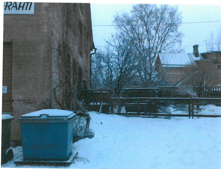
Kuva 1. Huonekalutehtaan sisäpihanpuoleinen pääty, jonka eteen on aikoinaan tullut junarata.
