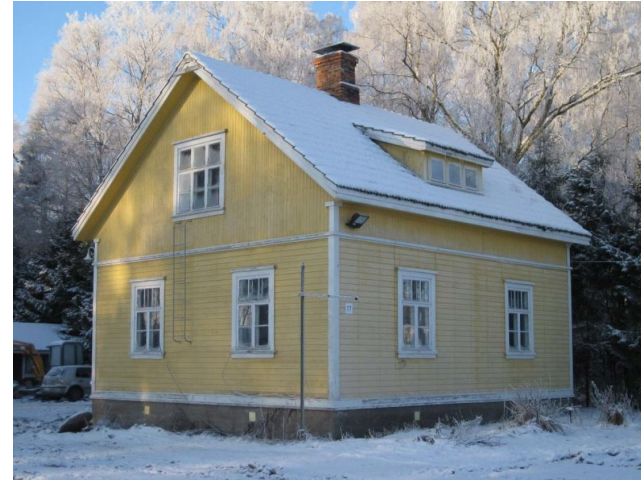
Puistola; kuva Kortelan, Vasaraisten ja Soukaisten kylien rakennusinventointiraportista.
